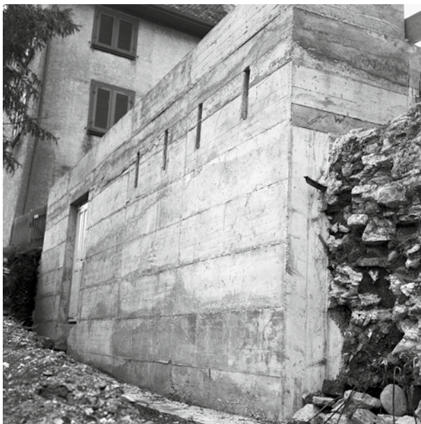
Abb. 41: Kaiseraugst/AG, St. Gallus (Grabung 1965.002). Rheinseite des Schutzbaus. Gegen Südosten. Links Rohzustand, rechts mit Kalksteinverblendung.
