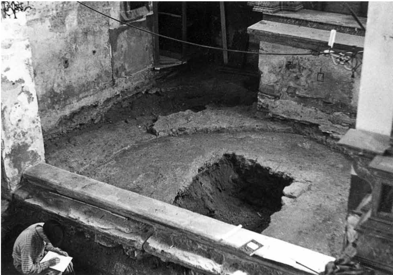
Abb. 116: Kaiseraugst/AG, St. Gallus (Grabung 1960.002). Chor. Apsis MR 80 im Zustand von Bauzustand IVc mit Altar MR 87 und Boden Sch 86. Gegen Nord-osten. Im Vordergrund die Chorstufen So 115.
