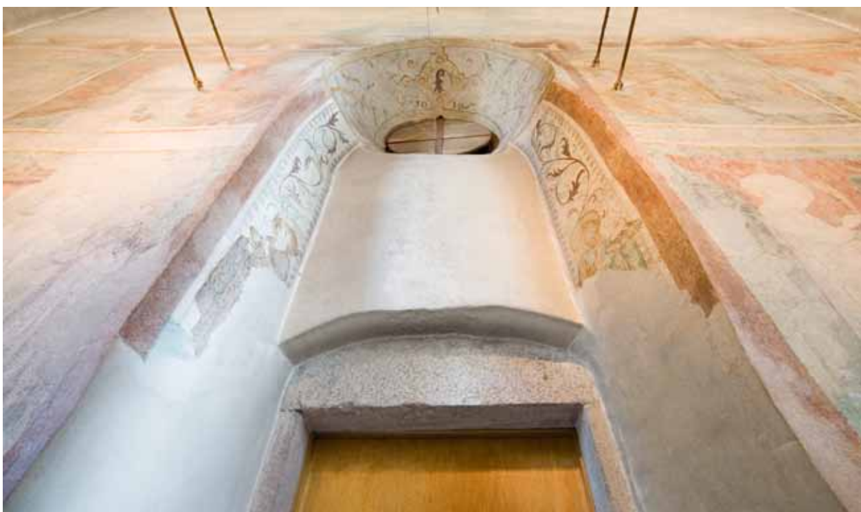
Abb. 20: Kaiseraugst/AG, St. Gallus. Chor-Ostmauer. Gegen Osten. Tür 144, Leibungen des Fensters Fen 142 und oculus Fen 143 mit Baudatum 1619.
