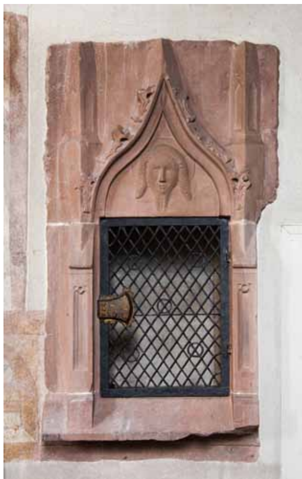
Abb. 19: Kaiseraugst/AG, St. Gallus. Spätgotisches Sakramentshäuschen So 145 in der Chor-Nordmauer.
