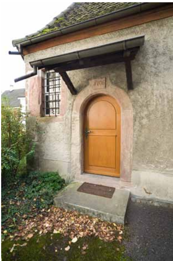
Abb. 18: Kaiseraugst/AG, St. Gallus. Eingang Tür 135 zur Sakristei mit Baudatum 1706 auf dem Sturz. Gegen Südosten.
