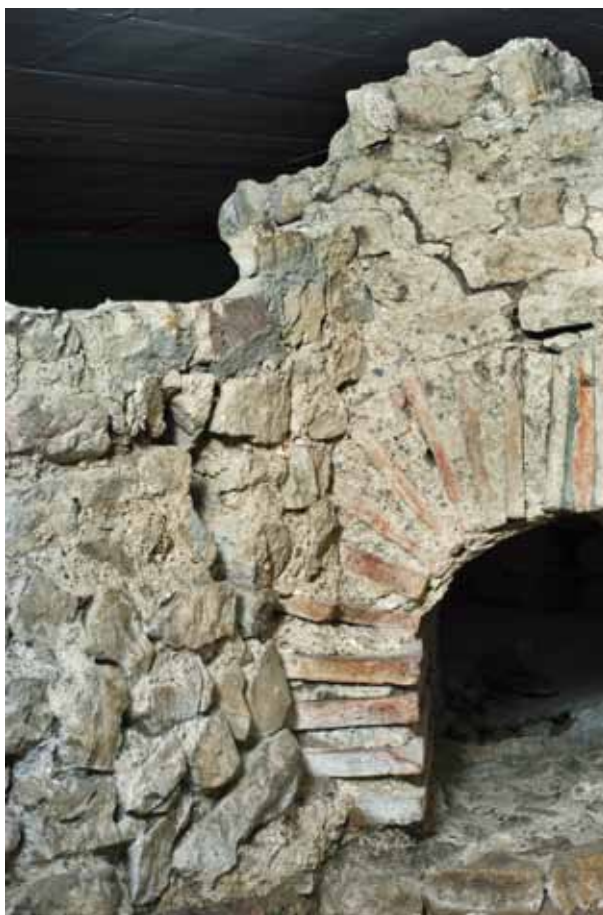
► Abb. 29: Kaiseraugst/AG, St. Gallus (Grabung 2005–2006.005). Schutzbau, Feld 4. Gegen Westen. Ecke zwischen Ostmauer MR 8 des Kaltwasserbeckens (links) und Präfurnium So 119 der kleinen Exedra MR 7 (rechts). Rechts unten drei Steine der Abbruchkrone von Exedra MR 33.
