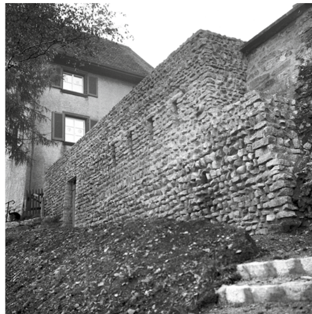
Abb. 41: Kaiseraugst/AG, St. Gallus (Grabung 1965.002). Rheinseite des Schutzbaus. Gegen Südosten. Links Rohzustand, rechts mit Kalksteinverblendung.
