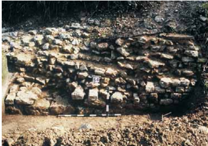
Abb. 42: Augst BL, Amphitheater-Sichelengraben (Grabung 1982.055). Arenazugang-Ost, Nordseite mit MR B12. Ansicht von Südwesten, mit an die Gewändequader der nördlichen porta postica anschliessender Zone. Man beachte die Mauertechnik mit dem Schalenmauerwerk aus Muschelkalk-Handquadern und dem lagig eingebrachten Mauerkern aus Kalkbruchsteinen und beigem Kalkmörtel.
