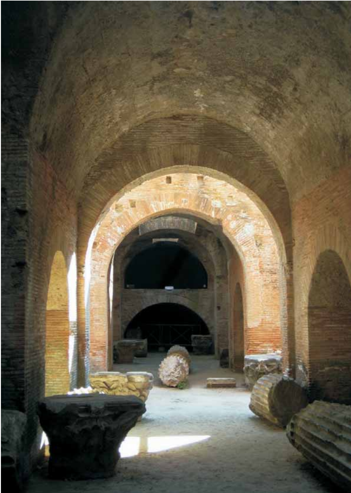
Abb. 227: Puteoli/Pozzuoli, Kampanien (I). Untergeschoss des flavischen Amphitheaters; Querachse mit Verbindungsgängen und Schachtöffnungen für die Liftsysteme im Gewölbescheitel. Der heller beleuchtete Teil im Zentrum zeigt den offenen Längsgraben für den Bühnendekor, der das Gewölbesystem der Querachse unterbricht.
