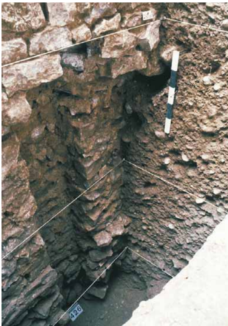
Abb. 78: Augst BL, Amphitheater-Sichelengraben (Grabung 1986.057). Arenazugang-West, Nordseite; Spundwandkonstruktion bei Mauer B17, Ansicht von Norden. Im oberen Bildteil das opus vittatum-Mauerwerk von MR B17 mit der noch erhaltenen dreireihigen Abfasung am linken Bildrand. Darunter die Spuren der hölzernen Spundwandkonstruktion im Überblick; gut sichtbar die Negative der massiven Vertikalpfosten und die Lage der ehemaligen Horizontalhölzer, die dazu geführt haben, dass nach Verrottung des Holzes der aufgehende Teil des Mauerwerks deutlich überhängend ist. Rechts im Bild das Grabungsprofil Beilage 30: Profil B31.
