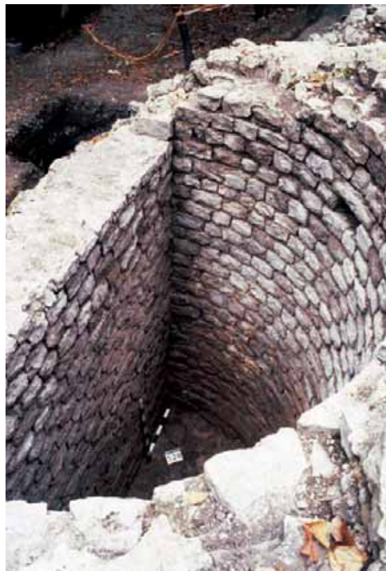
Abb. 68: Augst BL, Amphitheater-Sichelengraben (Grabung 1986.057). Arenazugang-West, Nordseite; Aufsicht auf Mauer B17. Gut erkennbar ist die Ausbildung als Stützmauerkonstruktion mit integrierten halbkreisförmigen Entlastungsbögen. Links im Bild der vollständig ausgehobene Entlastungsbogen E1. Der Schnitt am oberen Bildrand ermöglichte eine Ansicht an die Rückseite von MR B17 mit den charakteristischen Spuren einer hölzernen Spundwandkonstruktion (vgl. Abb. 77–82).
