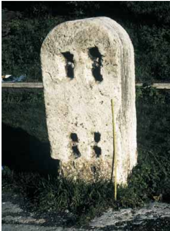
Abb. 155: Rom, Latium (I), Amphitheatrum Flavium (links); Puteoli/Pozzuoli, Kampanien (I), flavisches Amphitheater (rechts). Sogenannte «Cippi», die als Begrenzung des zum Amphitheater gehörenden Vorplatzes dienten und in welche mittels Balkenlöcher (links) oder mittels Nuten (rechts) Holzabsperungen zur Kanalisierung des Publikums eingesetzt werden konnten.
