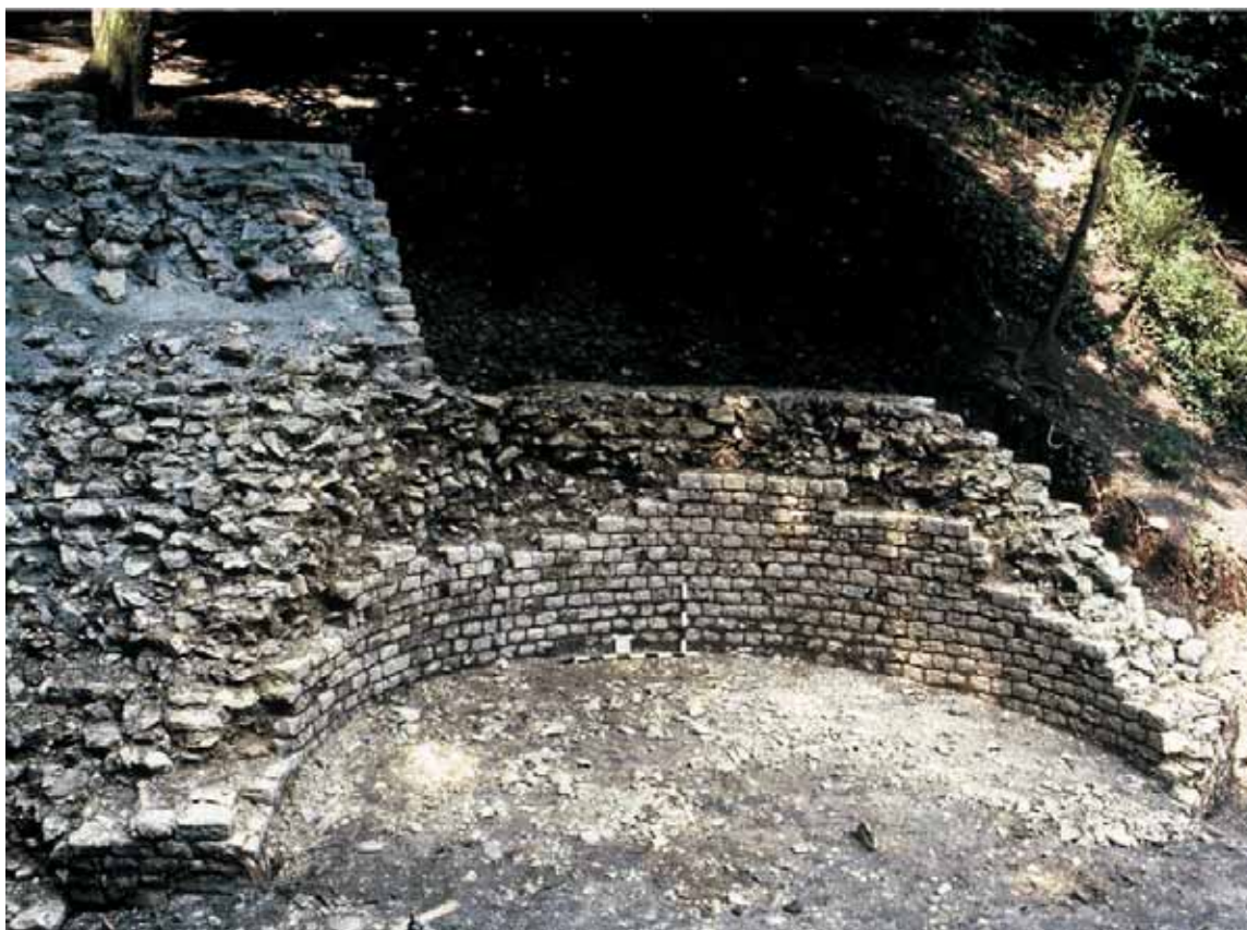
Abb. 125: Augst BL, Amphitheater-Sichelengraben (Grabung 1982.055; 1986.057). «Westcarcer» (sacellum?), rückwärtige, als halbkreisförmige Apsis ausgebildete Mauer B29, Ansicht von Südwesten während der Freilegung.
