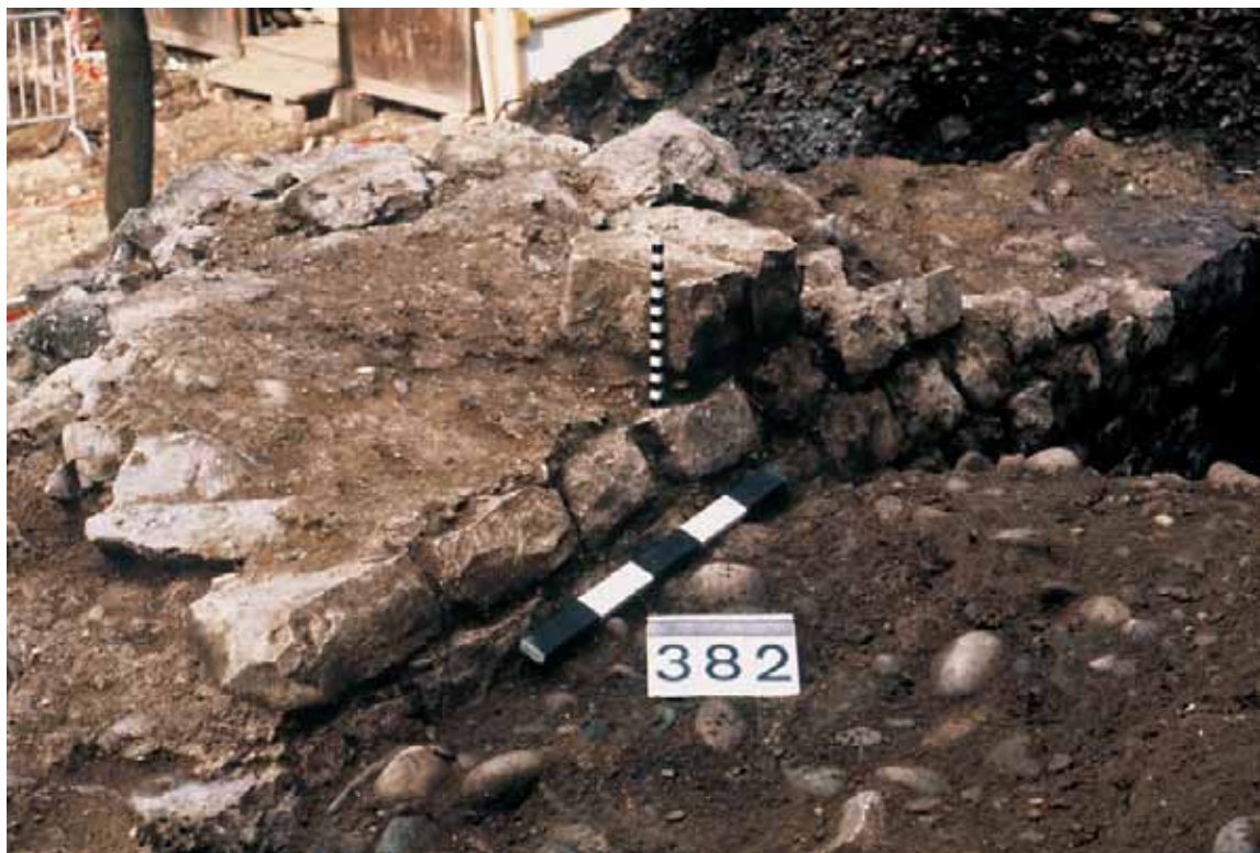
Abb. 72: Augst BL, Amphitheater-Sichelengraben (Grabung 1986.057). Arenazugang-West, Nordseite. Ansicht von Osten an die Rückseite von Mauer B17 mit der drei Kalksteinlagen starken Abfasung, die für eine Reduktion der Mauerstärke um gesamthaft 15 cm sorgt.
