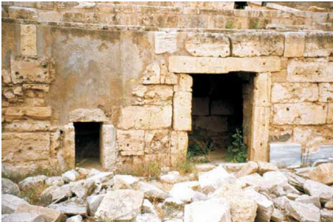
Abb. 220: Lepcis Magna/Lebda, Tripolitanien (Libyen). Amphitheater; Bereich des westlichen Arena-Hauptzugangs. Übersicht mit südlicher porta postica und anschließender Tierpforte. In der Podiumsmauer ist ein nischenartiger Rücksprung rekonstruiert, in dem die Schiebetür nach oben gezogen werden konnte.
