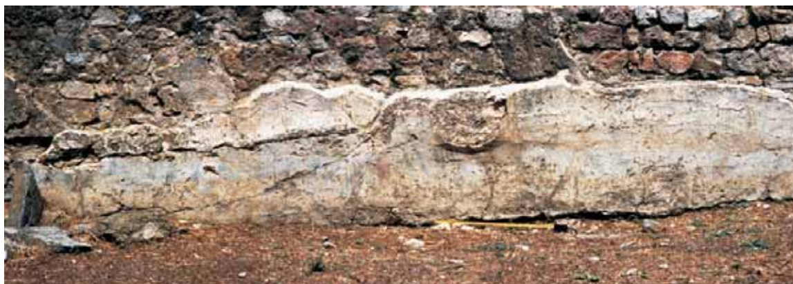
Fig. 303: Albingaunum/Albenga, Ligurie (I). Mur de podium de l'amphithéâtre d'Albenga. Détail du décor d'imitation de cipolin avec sens des veines inversé après les bandes rouges de séparation entre les plaques.
