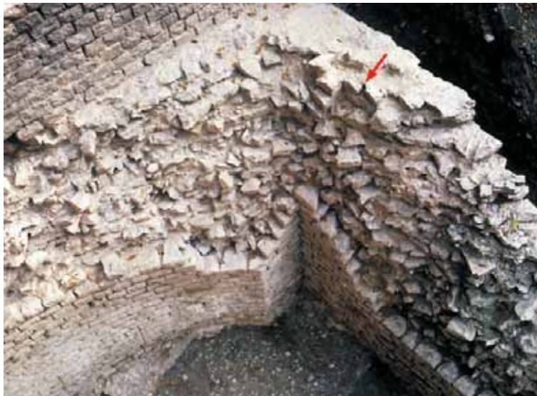
Abb. 103: Augst BL, Amphitheater-Sichelengraben (Grabung 1986.057). «Nordcarcer», Aufsicht auf die Mauerecke MR B4/MR B5 von Südwesten. Am oberen Bildrand ist der Mörtelglatzstrich erkennbar, der vermutlich bereits in antiker Zeit den oberen Abschluss der Mauerkronen markierte. Der Pfeil verweist auf eine sorgfältig angebrachte Abmauerung im Kernmauerwerk von MR B5, die als Auflager für einen rund 35 cm x 35 cm starken Deckenbalken aus Holz gedient hat.
