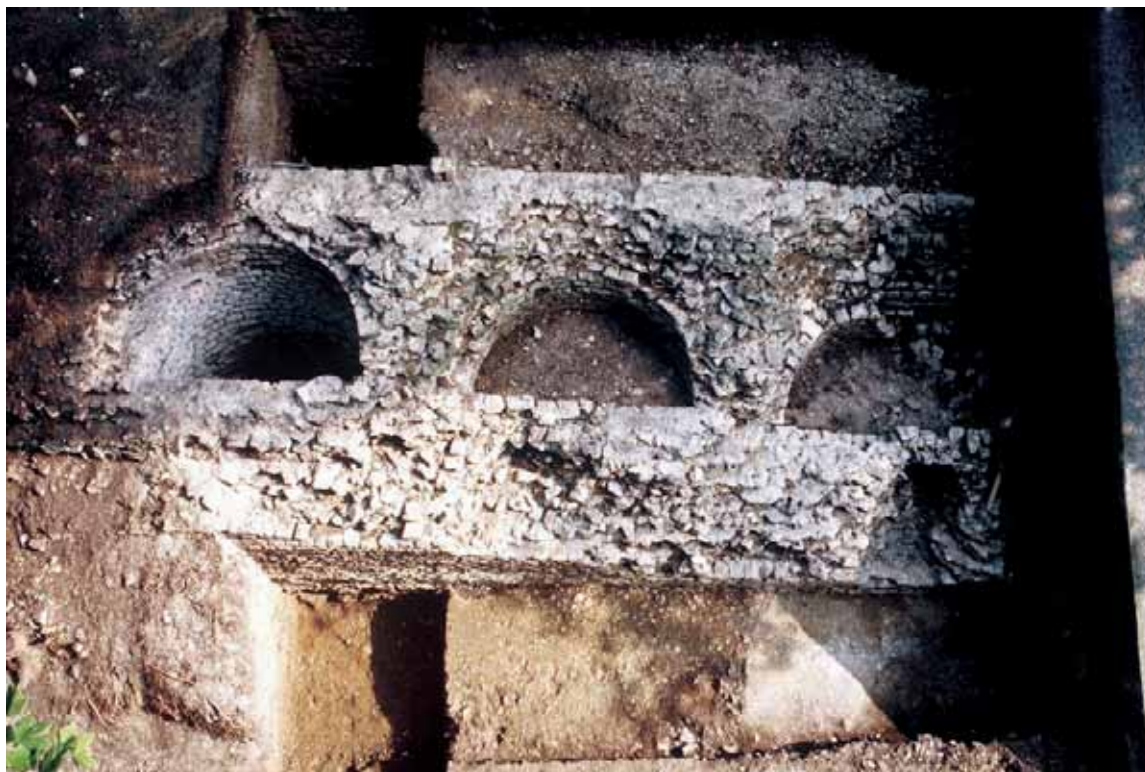
Abb. 68: Augst BL, Amphitheater-Sichelengraben (Grabung 1986.057). Arenazugang-West, Nordseite; Aufsicht auf Mauer B17. Gut erkennbar ist die Ausbildung als Stützmauerkonstruktion mit integrierten halbkreisförmigen Entlastungsbögen. Links im Bild der vollständig ausgehobene Entlastungsbogen E1. Der Schnitt am oberen Bildrand ermöglichte eine Ansicht an die Rückseite von MR B17 mit den charakteristischen Spuren einer hölzernen Spundwandkonstruktion (vgl. Abb. 77–82).
