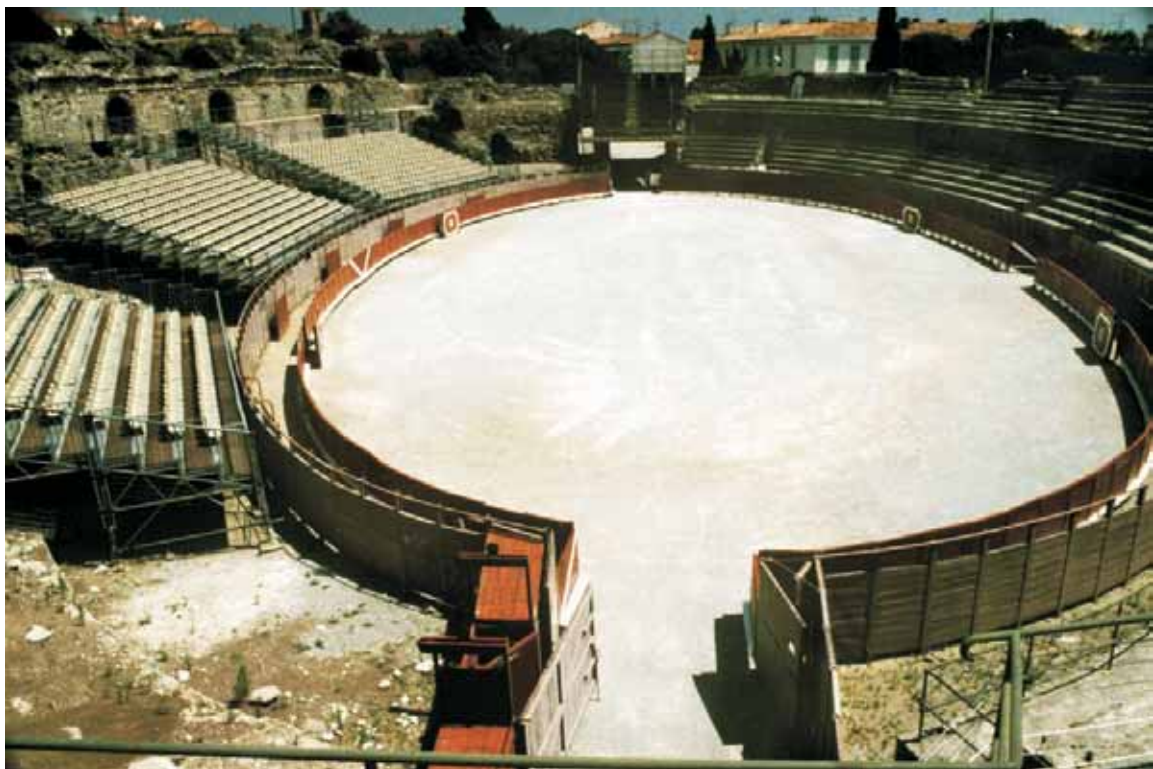
Abb. 177: Forum Iulii/Arènes de Fréjus, Provence (F). Arena des römischen Amphitheaters, modern umgerüstet zur Veranstaltung von Stierkämpfen (Einbau von calléjon und Sitzbänken); Zustand Juli 1996.
