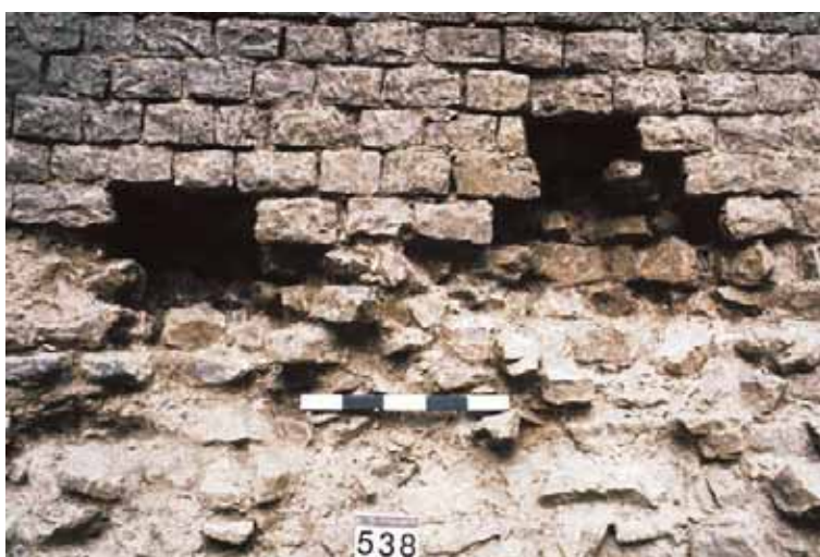
Abb. 105: Augst BL, Amphitheater-Sichelengraben (Grabung 1986.057). «Nordcarcer», Prae-cinctiomauer B6, Detailausschnitt. Zwei nahe beieinander liegende Löcher in MR B6, bei denen es sich eindeutig um im Zuge der Erosionsprozesse entstandene Ausbrüche des Schalenmauerwerks handelt. Während beim linken Ausbruch ganze Kalkhandquader herausgefallen sind, ist ein Teil der Schale des rechten Ausbruchs durch Frostsprengungen und Schäden am Steinmaterial zerstört worden.
