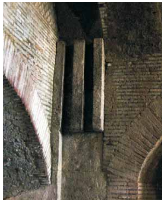
Abb. 245: Puteoli/Pozzuoli, Kampanien (I). Untergeschoss des flavischen Amphitheaters; nordwestlicher Zugang auf der Längsachse. Baubefund im Bereich des Schiebetores (vgl. Abb. 244), im Zentrum sind die steinernen Führungsrillen der Torkonstruktion erkennbar, rechts die südwestliche Nische des Vestibüls, links der Durchgang zum Untergeschoss.
