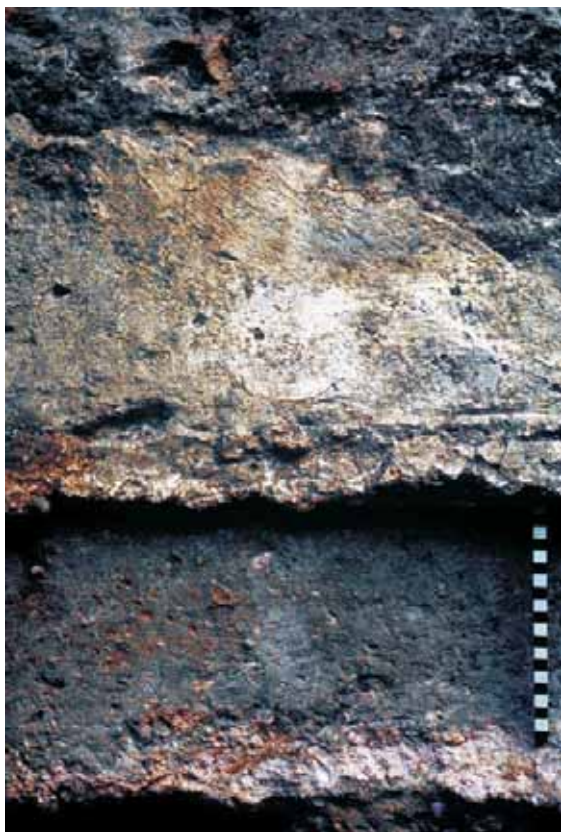
Abb. 18: Augst BL, Amphitheater-Sichelengraben (Grabung 1986.057). Podiumsmauer B1, Westhälfte (Bereich von Beilage 22: Profil B16/B29); Detail zu Abb. 17. Opus vittatum-Mauerwerk mit rötlichem Grundputz aus opus signinum und Resten der beiden Kalkmörtelverputze aus Phase BII.2 und Phase BIII.2.
