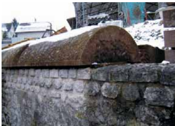
Fig. 298: Augst BL, amphithéâtre-Neun Türme. Chaperons de grès rouge en couronnement du mur de podium (anastylose).
