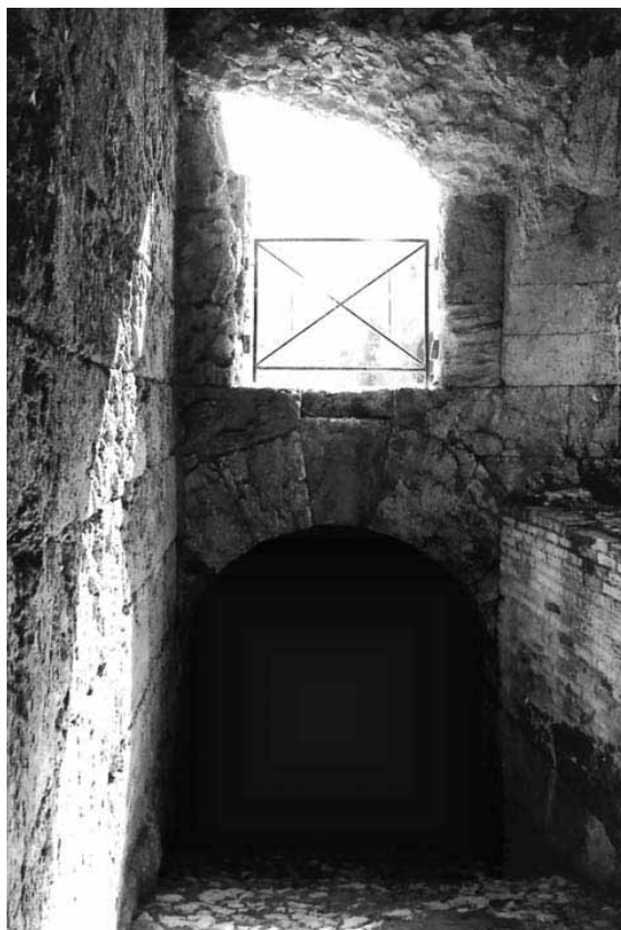
Abb. 248: Italica/Santiponce, Andalusien (E). Amphitheater; Ostseite; nördliche Zugangsrampe zum Untergeschoss (zur Situation vgl. auch Abb. 247).
