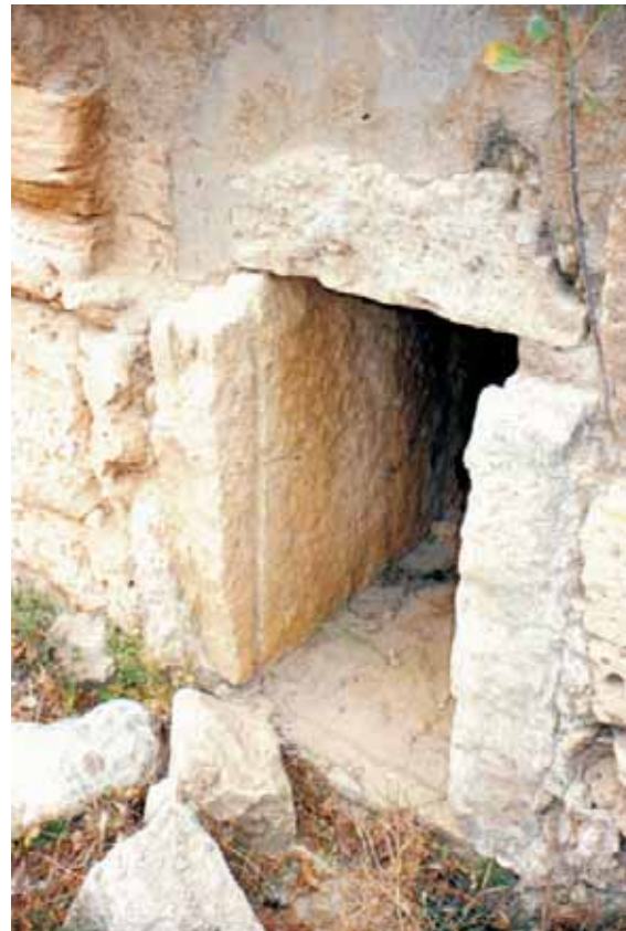
Abb. 219: Lepcis Magna/Lebda, Tripolitanien (Libyen). Amphitheater; Bereich des westlichen Arena-Hauptzugangs. Detail der südlichen Tierpforte mit deutlich erkennbarer Nut zum Einlassen einer vertikal laufenden Schiebetür, die vom podium her bedient worden sein muss.
