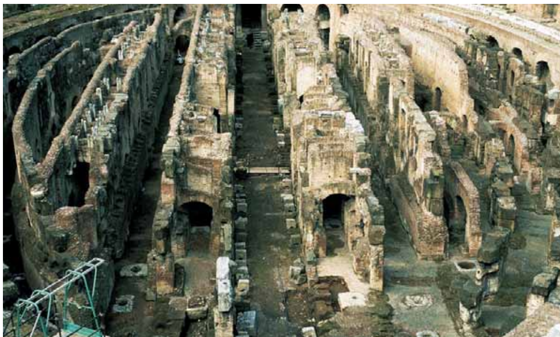
Abb. 259: Rom, Latium (I). Amphitheatrum Flavium, Blick von Westen über die verschiedenen Bauphasen der Arenasubstruktionen. Im Zentrum der Korridor H, der mit mobilen Rampen ausgestattet war, über die der Bühnendekor in die arena geschoben werden konnte (vgl. Abb. 254). Seitlich dazu die beiden Korridore F mit Hinweisen auf eine gleiche technische Ausstattung wie Korridor H (vgl. Abb. 253). Zwischen den Korridoren und links und rechts daran anschließend liegen Baustrukturen mit stabilisierenden Quermauern, die als Mündungsschächte für Aufzugsysteme ausgebildet waren. Im Vordergrund sind sogenannte Windensteine zu erkennen, die mit ihren typischen runden Ausarbeitungen zur Verankerung der bronzenen Drehlager der Haspelwinden dienten.
