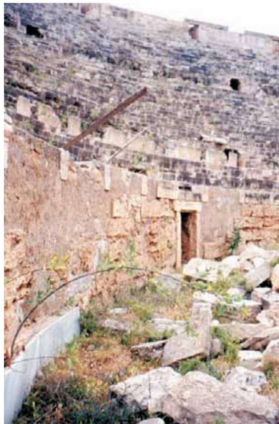
Abb. 279: Lepcis Magna/Lebda, Libyen. Amphitheater; Kalksteinblock mit ausgehauener, schräg verlaufender Halterung für die Balken einer Fangnetzkonstruktion. Situation im Mauerverband, Blick vom podium.
