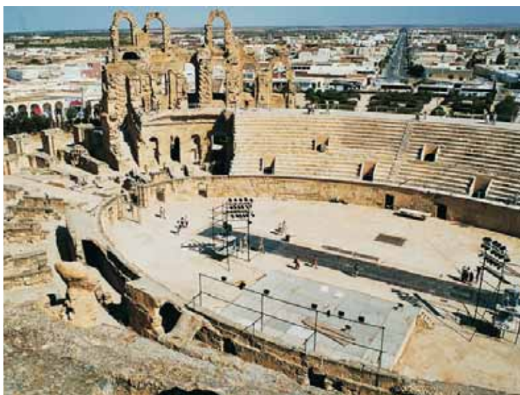
Abb. 192: Thysdrus/El Djem, Tunesien. Grosses Amphitheater; Osthälfte der arena mit Podiumsmauer und partiell rekonstruierter cavea. Türdisposition mit je zwei portae posticae beidseits des östlichen Arena-Hauptzugangs und vom Arenaumgang wegführenden Doppelpforten auf der Schmalachse.
