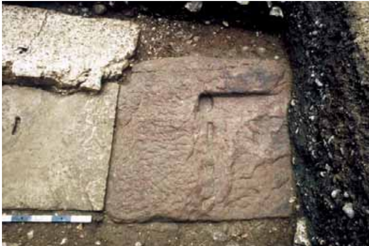
Abb. 54: Augst BL, Amphitheater-Sichelengraben (Grabung 1998.063). Arenazugang-Ost, Arenapforte; Detail zu Abb. 52. Aufsicht auf die Buntsandsteinschwelle des Arenators.
