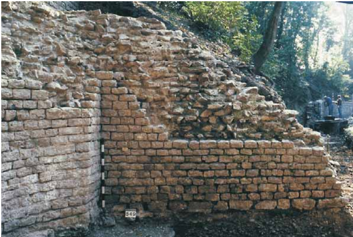
Abb. 97: Augst BL, Amphitheater-Sichelengraben (Grabung 1986.057). «Nordcarcer». Östliche Carcermauer B5 und Mauerverband zur Carcerrückwand B4; in der linken Bildhälfte ist der Ansatz der flach verlaufenden Apsis in der Rückwand des «carcers» erkennbar.
