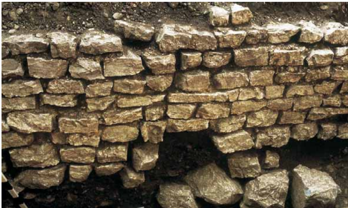
Abb. 135: Augst BL, Amphitheater-Sichelengraben (Grabung 1986.057). Podiumsmauer B1, westlicher Abschnitt, Ansicht von Norden (Rückseite); Nahtstelle von zwei Kreissegmentabschnitten der Grundrisskonstruktion. An der Nahtstelle im opus vittatum-Mauerwerk ist in den untersten fünf Steinlagen oberhalb des Fundaments deutlich eine Stossfuge erkennbar; ab der sechsten Steinlage verschwindet die Fuge. Das Fugenbild ist mit grösster Wahrscheinlichkeit als Resultat des Bauablaufs zu interpretieren und wohl kaum als Hinweis auf eine Umbauphase zu werten.
