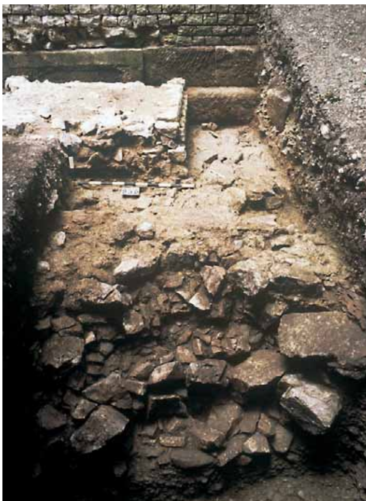
Abb. 88: Augst BL, Amphitheater-Sichelengraben (Grabung 1986.057). Arenazugang-West, Südseite; Fundamentmauer B23/B23a, Übersicht von Nordosten. Die mächtige Fundamentstücker besteht aus geschütteten Kalkbruchsteinen ohne Mörtelbindung, während die Oberfläche durch eine dicke Kalkmörtelschicht abgedeckt wird. Der nördliche Teil der Stücker ist durch einen späteren, nach Aufgabe des Amphitheaters entstandenen Erosionsgraben vollständig zerstört worden. In der linken Bildhälfte ist der sekundär (Phase BIII.2) errichtete, zweischalige Mauerkörper B23a erkennbar, der in dieser Zone eine Aufhöhung des Bodenniveaus voraussetzt.
