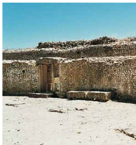
Abb. 215: Pompeji, Kampanien (I). Amphitheater; nördlicher Arena-Hauptzugang mit Pfostenhalterungen aus Stein zur Abgrenzung eines engen Korridors (vgl. Abb. 214). Detail einer Steinhaltung; Masse ca. 27 x 20 cm.
