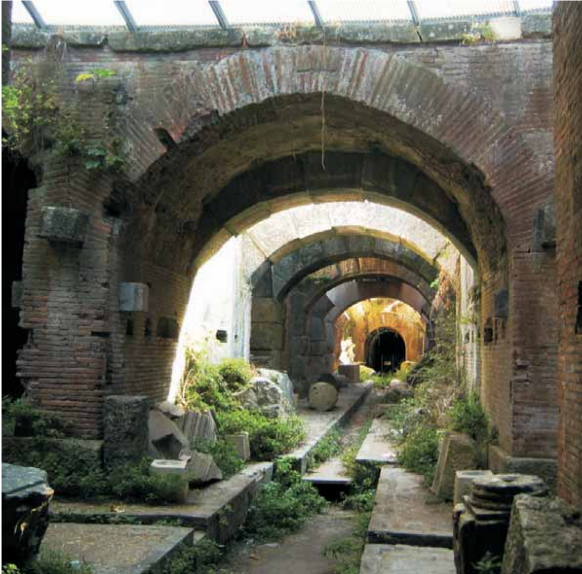
Abb. 250: Capua/St. Maria Capua Vetere, Kampanien (I). Grosses Amphitheater; Untergeschoss. Blick auf der Längsachse in die Fortsetzung unterhalb des nördlichen Arena-Hauptzugangs. Die Kanäle im Boden dienten zur Entwässerung des Untergeschosses. In den Wänden finden sich Kalksteinkonsolen und Ausbrüche, die mit der technischen Installation der Bühnenmaschinen und Lifte (pegmata) in Zusammenhang stehen dürften.
