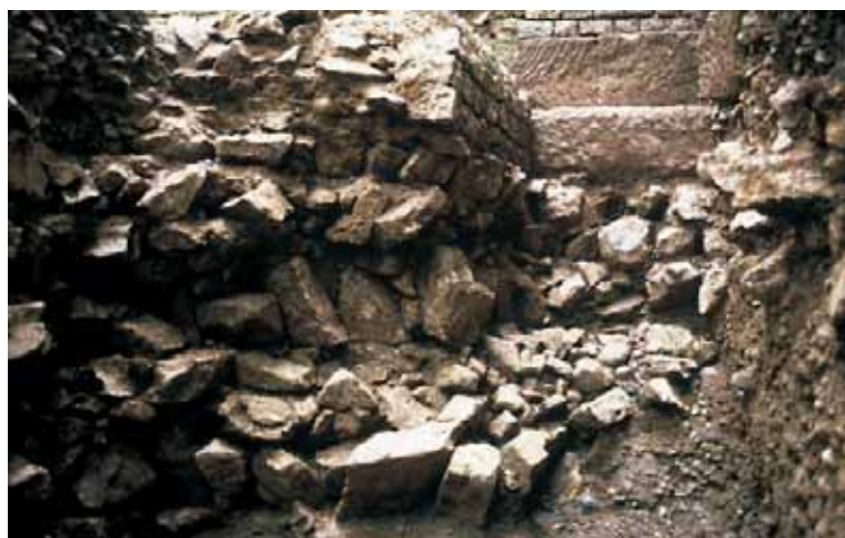
Abb. 88: Augst BL, Amphitheater-Sichelengraben (Grabung 1986.057). Arenazugang-West, Südseite; Fundamentmauer B23/B23a, Übersicht von Nordosten. Die mächtige Fundamentstücker besteht aus geschütteten Kalkbruchsteinen ohne Mörtelbindung, während die Oberfläche durch eine dicke Kalkmörtelschicht abgedeckt wird. Der nördliche Teil der Stücker ist durch einen späteren, nach Aufgabe des Amphitheaters entstandenen Erosionsgraben vollständig zerstört worden. In der linken Bildhälfte ist der sekundär (Phase BIII.2) errichtete, zweischalige Mauerkörper B23a erkennbar, der in dieser Zone eine Aufhöhung des Bodenniveaus voraussetzt.
