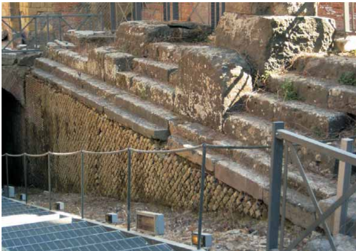
Abb. 241: Puteoli/Pozzuoli, Kampanien (I). Flavisches Amphitheater; nordwestlicher Arena-Hauptzugang mit den zur cavea führenden Treppen (rechts), dem Falz zur Aufnahme einer Holzabdeckung und dem Rampenabgang zum Untergeschoss (links).
