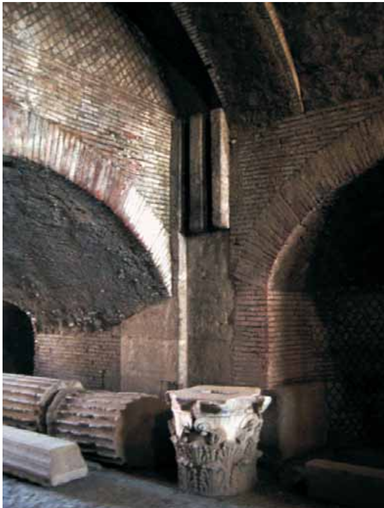
Abb. 245: Puteoli/Pozzuoli, Kampanien (I). Untergeschoss des flavischen Amphitheaters; nordwestlicher Zugang auf der Längsachse. Baubefund im Bereich des Schiebetores (vgl. Abb. 244), im Zentrum sind die steinernen Führungsrillen der Torkonstruktion erkennbar, rechts die südwestliche Nische des Vestibüls, links der Durchgang zum Untergeschoss.
