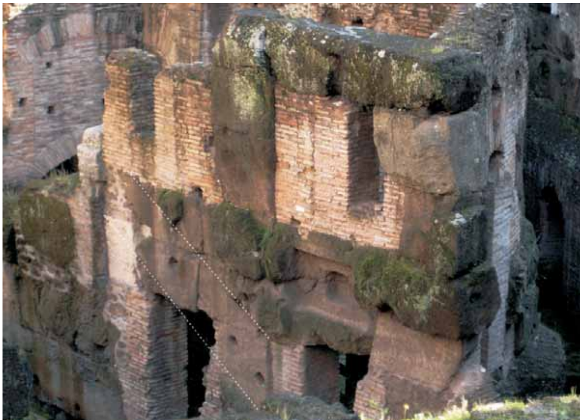
Abb. 252: Rom, Latium (I). Amphitheatrum Flavium; Untergeschoss, Blick von Südosten. Spuren von schräg nach oben führenden Rampen an den aus Tuffstein bestehenden Seitenwänden des zentralen «Bühnengrabens». Rechts davon eine grosse rechteckige und eine kreisrunde Einarbeitung im Tuffsteinmauerwerk, die mit technischen Einrichtungen der Bühnenmaschinerie (pegmata) in Zusammenhang stehen dürften.
