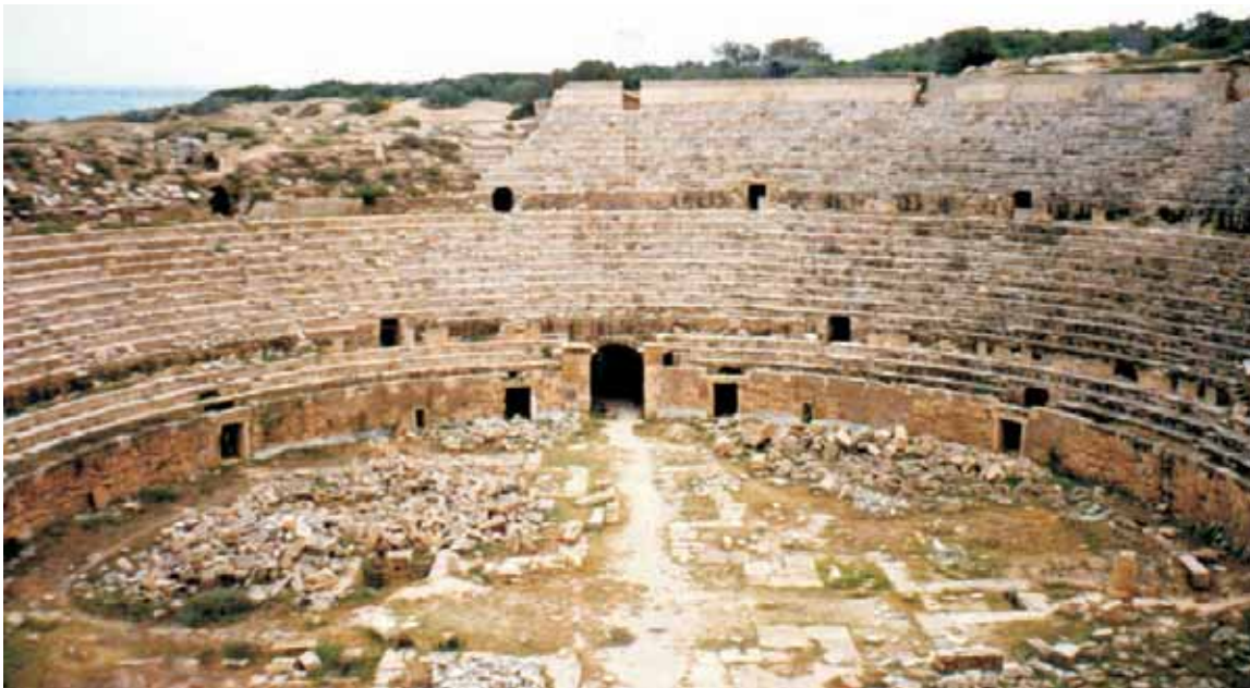
▼ Abb. 218: Lepcis Magna/Lebda, Tripolitani (Libyen). Amphitheater; östliche Arenahälfte, Übersicht. Erkennbar ist die Dreiteilung der caeva mit dem podium und zwei daran anschliessenden maeniana. Im Zentrum der östliche Arena-Hauptzugang mit beidseits anschliessender Podiumsmauer. Deutlich zu erkennen ist die Disposition der links und rechts an das Hauptportal (porta sanavivaria oder porta libitinen-sis) anschliessenden portae posticae, denen im Abstand von ca. 2,00 m niedrige und schmale Tierporten angegliedert sind. In der unteren Bildhälfte die arena mit den Begrenzungsmauern des kreuzförmig angelegten Untergeschosses.
