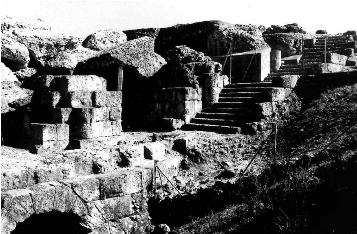
Abb. 144: Italica/Santiponce, Andalusien (E). Amphitheater; nordöstlicher Abschnitt der Peripherie. Vergleichsbeispiel für der Peripherie entlangführende Treppenläufe als Verbindung zwischen den verschiedenen Eingängen.
