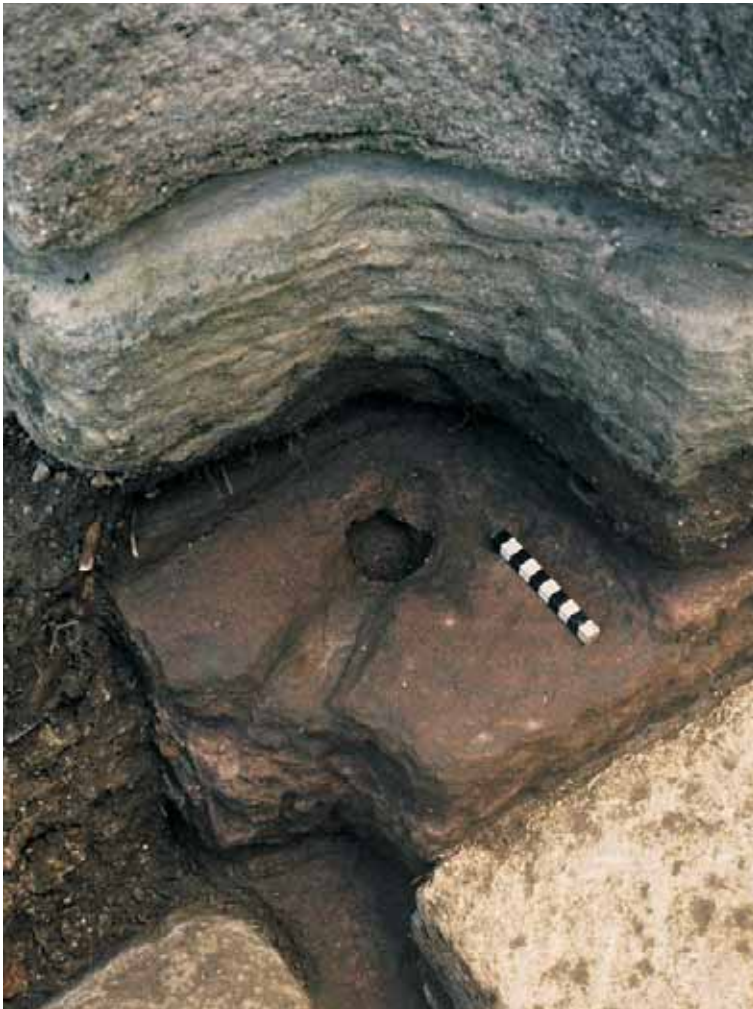
Abb. 59: Augst BL, Amphitheater-Sichelengraben (Grabung 1998.063; 2007/08.052). Arenazugang-Ost, Arenapforte; Detail zu Abb. 58. Drehpfanne mit Eisenspuren und Nut zum Einschieben der Türkonstruktion der nördlichen porta postica, eingearbeitet in den unteren der beiden in situ verbliebenen Gewändequader.
