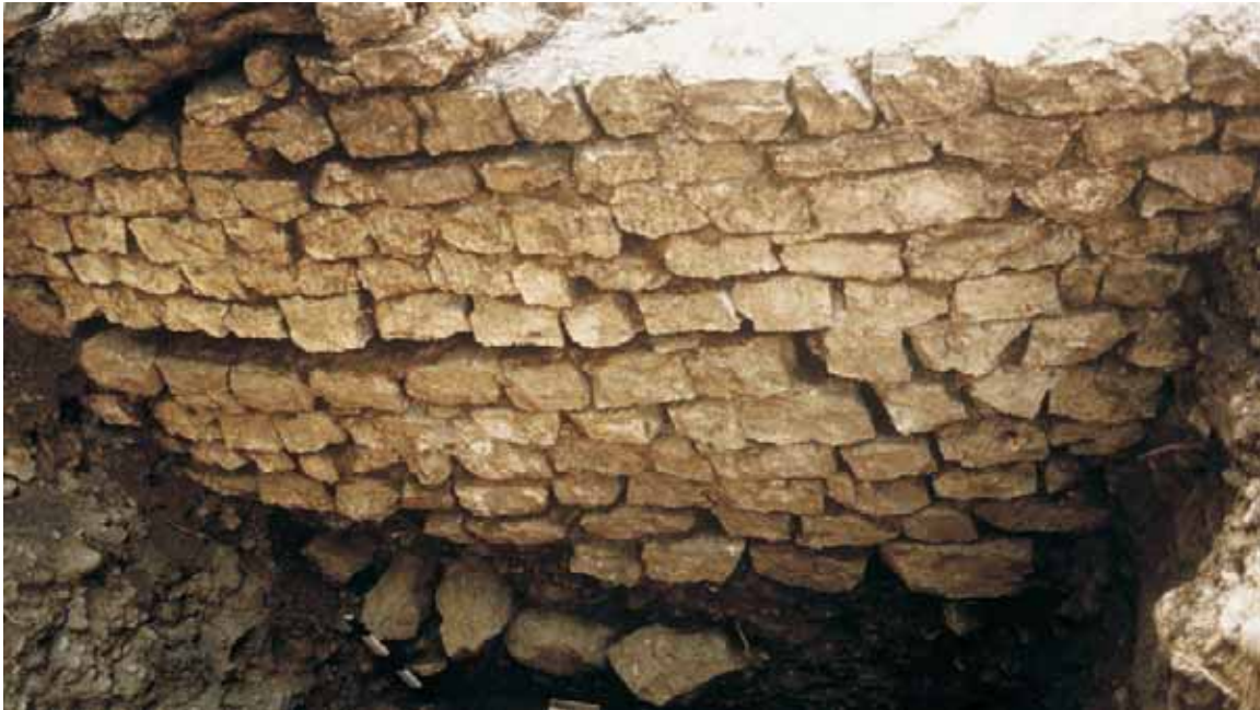
Abb. 16: Augst BL, Amphitheater-Sichelengraben (Grabung 1986.057). Podiumsmauer B1, Westhälfte (Bereich zwischen Beilage 22: Profil B16/B29 und dem «Westcarcer»); Zone der antiken Baugrube. Ansicht an die aus grob gerichteten Kalkbruchsteinen bestehende Rückseite von Mauer B1. In Folge der schwachen, einlagigen Fundamentierung (vgl. die Kalkbruchsteine am unteren Bildrand) kam es, ausgelöst durch den Hangdruck, zu teilweise starken Verschiebungen der Mauer in der Zeit nach der Aufgabe des Amphitheaters. Der gesamte Mauerkörper ist hier in Richtung arena abgeschert, so dass sich zwischen dem in situ verbliebenen Rest des Fundaments und dem aufgehenden Mauerwerk aus der Baugrube nachgerutschter Kies akkumulieren konnte. Der obere Mauerbereich ist durch die Hangerosion bereits stärker verschoben, weshalb sich sekundär eine breite Horizontalfuge im Kalksteinmauerwerk gebildet hat.
