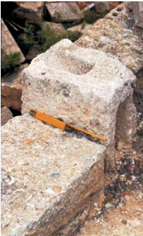
Abb. 279: Lepcis Magna/Lebda, Libyen. Amphitheater; Kalksteinblock mit ausgehauener, schräg verlaufender Halterung für die Balken einer Fangnetzkonstruktion. Situation im Mauerverband, Blick vom podium.
