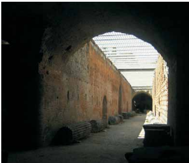
Abb. 228: Puteoli/Pozzuoli, Kampanien (I). Untergeschoss des flavischen Amphitheaters; Längsachse mit Graben zur Aufnahme des Liftsystems für den Bühnendekor.
