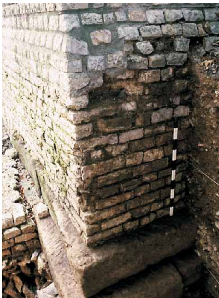
Abb. 86: Augst BL, Amphitheater-Sichelengraben (Grabung 1986.057). Arenazugang-West, Nordseite. Ansicht von Nordosten an den als Stützpfeiler ausgebildeten Ostabschluss von Mauer B22. Gut erkennbar sind das zweilagige Quaderfundament sowie die Fluchtkorrektur am aufgehenden Mauerwerk, die zeigt, dass die Oberfläche der oberen Quaderlage gleichzeitig als Rissniveau zur Definition des exakten Grundrissverlaufs verwendet worden ist.
