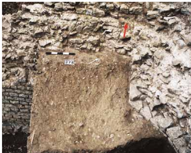
Abb. 104: Augst BL, Amphitheater-Sichelengraben (Grabung 1986.057). «Nordcarcer», Ansicht an die Mauerecke MR B3/MR B4 von Südosten. Der Pfeil verweist auf ein analoges Balkenlager wie in Abb. 103.
