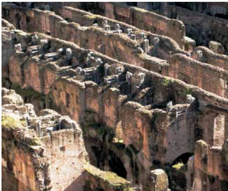
Abb. 261: Rom, Latium (I). Amphitheatrum Flavium, Untergeschoss; Blick von Osten (oben), resp. Südosten (unten). In Reihen angeordnete Schächte des zur jüngsten Phase gehörenden Auf- zugsystems, bei dem mehrere Lifte gleichzeitig und über eine einzige Seilwinde gesteuert in die arena befördert werden konnten.
