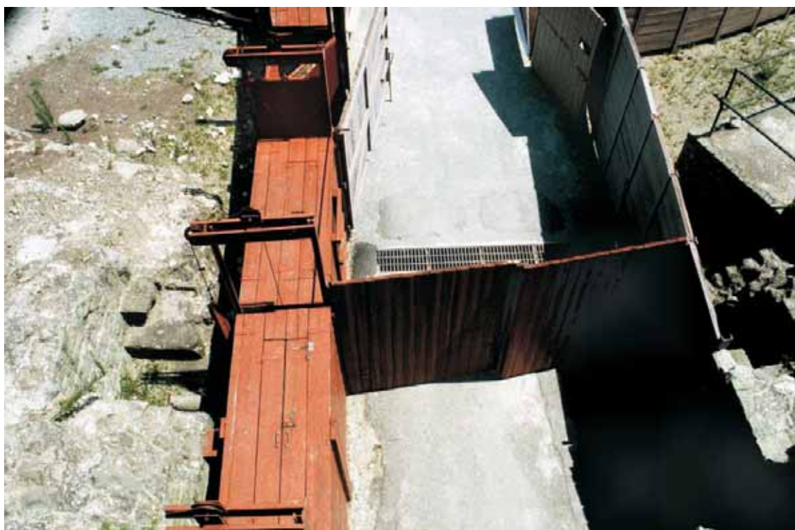
Abb. 205: Forum Iulii/Fréjus, Provence (F). Arena des römischen Amphitheaters, Detail des geschlossenen Holztunnels von Abb. 204. Gut erkennbar die Aufzüge für die vertikal laufenden Schiebetore zur Abtrennung in einzelne Kompartimente. In der Holzabdeckung jedes Kompartiments sind schmale, aufklappbare Luken zu erkennen, durch die der Stier bei Bedarf mit einem spitzen Eisen gereizt werden kann. Man beachte zudem die Doppeldisposition der Arenatore im Bildzentrum.
