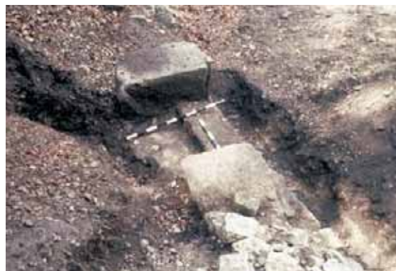
Abb. 119: Augst BL, Amphitheater-Sichelengraben (Grabung 1982.055; 1986.057). «Südcarcer», erhaltener Baubefund der Schwellensituation, Ansicht von Nordosten. Zustand vor Ausführung der Rekonstruktionsarbeiten von 1984/85. Deutlich erkennbar die Reste der Türgewände der östlichen porta postica, sowie die dazwischen gespannte Türschwelle aus kreidigem Korallenkalk. Beim Gewändequader links im Bild ist eine massive Abarbeitung zu erkennen, die auf eine sekundäre Überarbeitung des Türfalzes schließen lässt. Beim Gewändequader rechts von der Schwelle fällt die deutliche Bosse am hinteren Ende auf, die darauf hinweist, dass hier eine Treppenkonstruktion auf ein oberhalb der Bosse gelegenes Bodenniveau geführt hat. Am rechten Bildrand ist zudem ein noch in situ liegender Sandsteinquader von der sekundären Übermauerung der westlichen porta postica erkennbar (vgl. Abb. 117,10).
