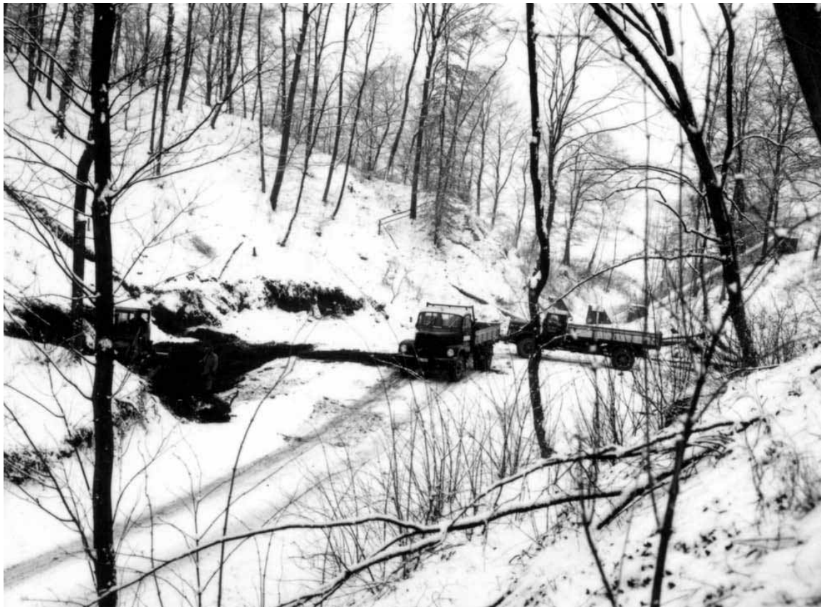
Abb. 11: Augst BL, Amphitheater-Sichelengraben. Ausschachtungsarbeiten in der arena im Winter 1961/62 unter Einsatz schwerer Baumaschinen.
