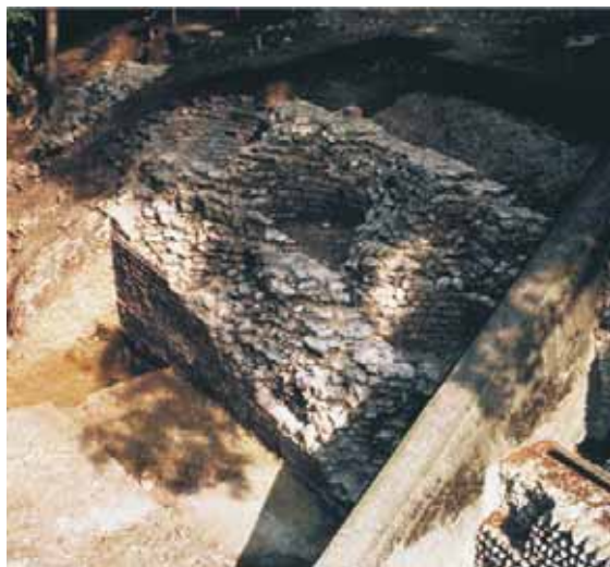
Abb. 69: Augst BL, Amphitheater-Sichelengraben (Grabung 1986.057). Arenazugang-West, Nordseite; Mauer B17, Ansicht von Südosten. Konstruktiver Aufbau der Stützmauer mit den in den Mauerkörper integrierten Entlastungsbögen und dem deutlich lagig eingebrachten Mauerkern. Rechts im Vordergrund die bereits unter Abb. 67 erwähnte Tanksperre.
