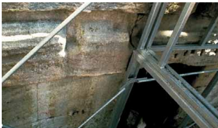
Abb. 229: Arelate/Arles, Provence (F). Arena des Amphitheaters; Blick in das die gesamte Arenafläche einnehmende Untergeschoss. Gut erkennbar sind die Einarbeitungen im Kalksteinmauerwerk der Podiumsmauer, die zur Aufnahme der Tragbalken für den hölzernen Arenaboden gedient haben. Unterhalb der Balkenlager befindet sich eine der Zugangsportalen zum Untergeschoss.
