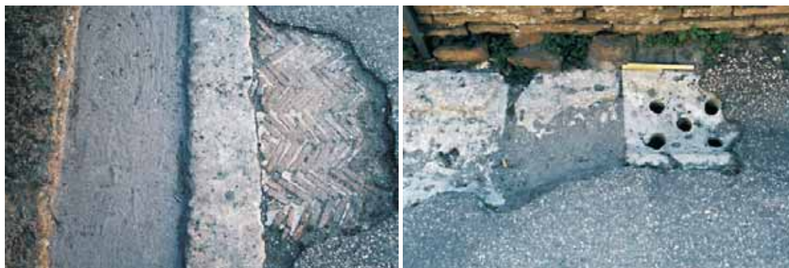
Abb. 24: Rom, Latium (I); Amphitheatrum Flavium. Beispiele für im Bodenbelag geführte Rinnen zur oberirdischen Ableitung von Niederschlagswasser. Links: Travertinrinne mit anstossendem, originale opus spicatum-Boden. Rechts: Travertinrinne mit fünfblöchrigem Einlaufschacht über einem vertikal verlaufenden Fallstrang. Länge des Massstabs: 20 cm.
