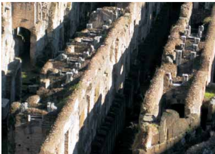
Abb. 261: Rom, Latium (I). Amphitheatrum Flavium, Untergeschoss; Blick von Osten (oben), resp. Südosten (unten). In Reihen angeordnete Schächte des zur jüngsten Phase gehörenden Auf- zugsystems, bei dem mehrere Lifte gleichzeitig und über eine einzige Seilwinde gesteuert in die arena befördert werden konnten.
