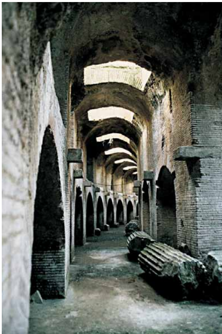
Abb. 263: Puteoli/Pozzuoli, Kampanien (I). Untergeschoss des flavischen Amphitheaters; nord-westlicher Abschnitt des peripheren Umgangs, Übersicht. Im Deckengewölbe sind die rechteckigen Austrittsöffnungen für die Aufzüge erkennbar, in den Seitenwänden die Konsolsteine, welche als Auflager für die Balkenkonstruktion der Liftführungen dienten.
