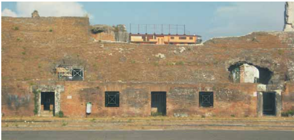
Abb. 195: Capua/St. Maria Capua Vetere, Kampanien (I). Arena und Podiumsmauer des grossen Amphitheaters; Blick im Bereich der Schmalachse. Die Podiumsmauer zeigt eine von zwei grossen Fenstern flankierte porta postica auf der Achse, die zu einem hinter der Mauer liegenden «carcer» mit sacellum führt. Die beiden Fenster werden ihrerseits wiederum von je einer porta postica flankiert, die Zugang zu weiteren seitlichen Carcerräumen gewähren. Zwar führen nicht alle drei Pforten in denselben Raum, dennoch entspricht die Situation nutzungstechnisch gesehen einer Dreipforten-Disposition.
