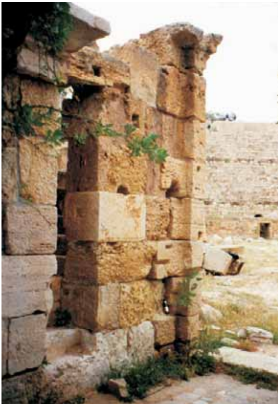
Abb. 198: Lepcis Magna/Lebda, Tripolitani (Libyen). Amphitheater. Östlicher Arena-Hauptzugang (auf der Längsachse) mit Verbindungstreppe zum podium auf der Südseite.
