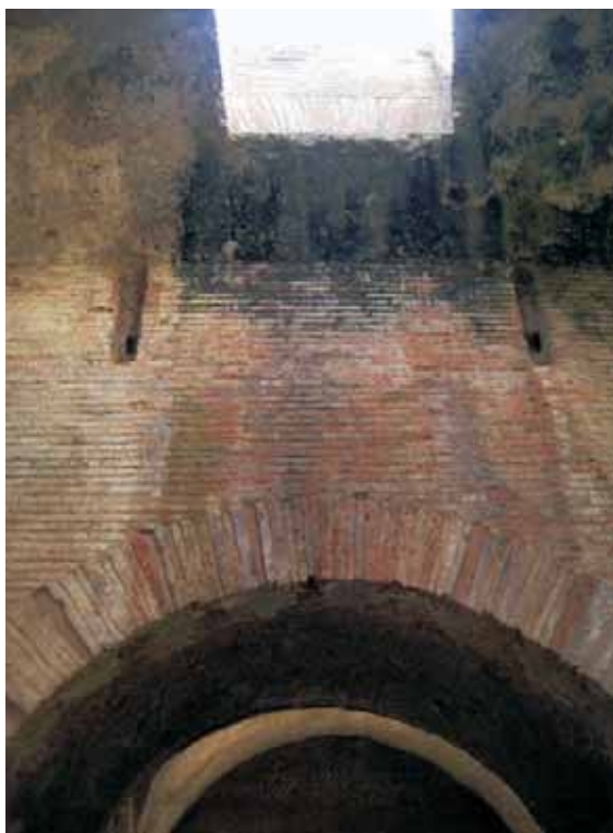
Abb. 269: Puteoli/Pozzuoli, Kampanien (I). Untergeschoss des flavischen Amphitheaters; Innenwand des peripheren Korridors mit den Aufzugvorrichtungen. Oberhalb der Gewölbekanten, korrespondierend mit den Austrittsöffnungen (am oberen Bildrand) finden sich direkt unter dem Gewölbeansatz jeweils paarweise links und rechts der Öffnungen Spuren von im Ziegelmauerwerk verankerten Holzkonstruktionen. Die ins Mauerwerk eingelassenen Hölzer dienten vermutlich der Befestigung von Umlenkrollen für das Hebesystem der Aufzugvorrichtungen (vgl. Abb. 265,9).
