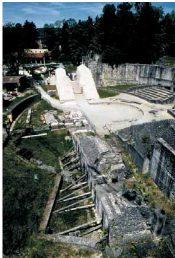
Abb. 10: Augst BL, Amphitheater-Neun Türme (Grabung 1992–2007.055). Blick von Süden mit Überlagerung der verschiedenen Theaterbauten. Die massiven, vier Meter breiten Aditusmauern des jüngeren szenischen Theaters durchschneiden die arena des ehemaligen Amphitheaters (Bildmitte). In der rechten Bildhälfte sind der «Ostcarcer» und die Überreste der stark restaurierten Sitzstufen des podiums zu erkennen.
