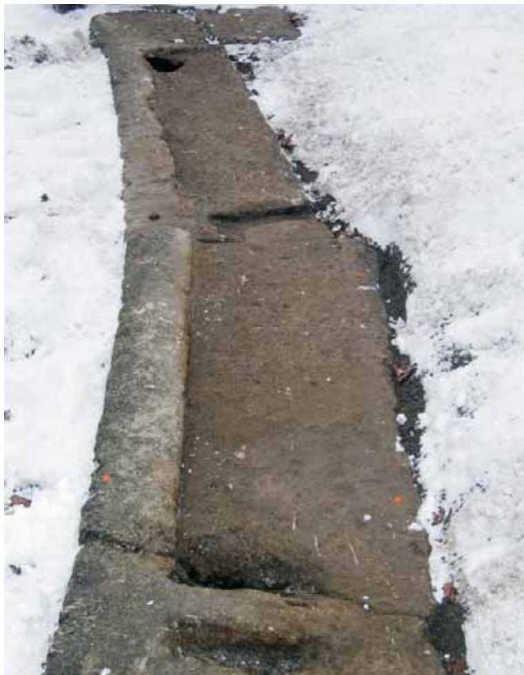
Abb. 275: Vindonissa/Windisch, Aargau (CH). Amphitheater; Sandsteinschwelle des westlichen Arena-Hauptzugangs am Übergang zur arena. Gut erkennbar die runden Vertiefungen, die als Drehpfannen für die Lager der Arenatore dienten. In der Mitte der Schwelle eine L-förmige Rinne zum Einsetzen des eisernen Riegels der Torverriegelung.
