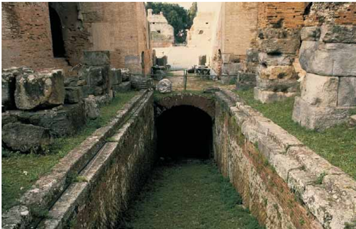
Abb. 242: Puteoli/Pozzuoli, Kampanien (I). Flavisches Amphitheater; ins Untergeschoss führende Rampe im südöstlichen Arena-Hauptzugang. Gut erkennbar ist die Steinrahmung mit dem breiten, abgearbeiteten Falz, der zur Aufnahme der Rampenabdeckung diente. Die Abarbeitung ist durchgehend und besteht nicht aus einzelnen Balkenlagern, was auf eine horizontal verschiebbare Konstruktion hinweisen könnte.
