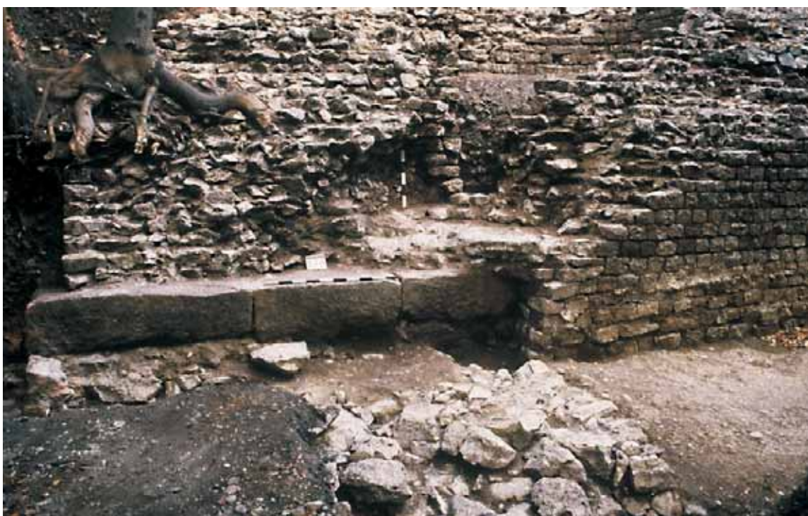
Abb. 85: Augst BL, Amphitheater-Sichelengraben (Grabung 1986.057). Arenazugang-West, Nordseite. Ostabschluss von Mauer B17, Ansicht von Südwesten. Der als Stützpfiler ausgebildete Ostabschluss von MR B17 weist ebenfalls im Pfeilerbereich ein Fundament aus Buntsandsteinquadern auf, allerdings ist hier die Quaderbasis über der sich in der Quermauer B19 fortsetzenden Kalksteinstückung lediglich einlagig. An den Quaderseiten sind deutlich Anathyrosen erkennbar, die belegen, dass sich die Quaderlage auf die volle im Bild sichtbare Breite weiter nach Süden fortgesetzt hat. Die heute fehlenden Sandsteinquader sind vermutlich dem bereits in antiker Zeit erfolgten Steinraub zum Opfer gefallen.
