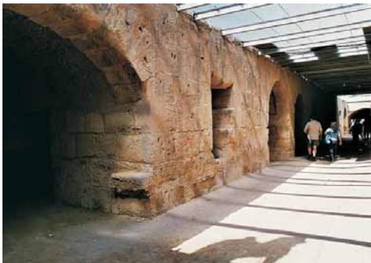
Abb. 232: Thysdrus/El Djem, Tunesien. Grosses Amphitheater; Untergeschoss. Seitenwangen des Längsgrabens mit Zugängen zu den anschlies- senden unterirdischen Kammern. An der Ober- kante der Mauer sind die Aussparungen für die Holzbalken der Grabeneindeckung erkennbar (zum Teil zum Einsetzen moderner Stahlträger wiederverwendet).
