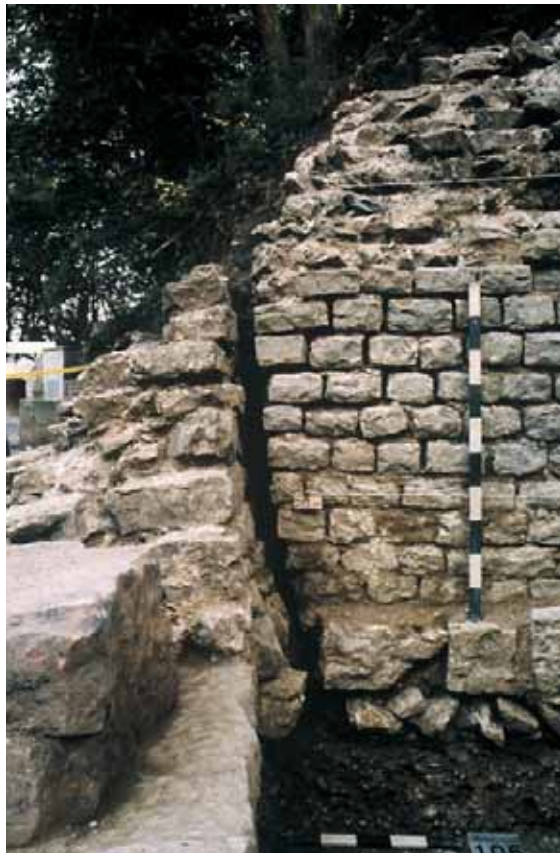
Abb. 96: Augst BL, Amphitheater-Sichelengraben (Grabung 1986.057). «Nordcarcer». Stossfuge zwischen westlicher Carcermauer B3 und Podiumsmauer B1. Die Fundamentoberkante der Carcermauern liegt auf derselben Höhe wie die Oberkante der Unterlagsschwelle im Eingangsbereich.
