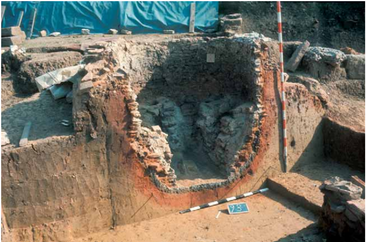
Abb. 34: Augst, Region 7C (Grabung 1968–1969.053). Blick auf das Profil durch die Heizkammer von Ofen ARE7C01.A.2008. Gut zu erkennen die aus Leistenziegelfragmenten konstruierte Ofenwand. Von Norden.
