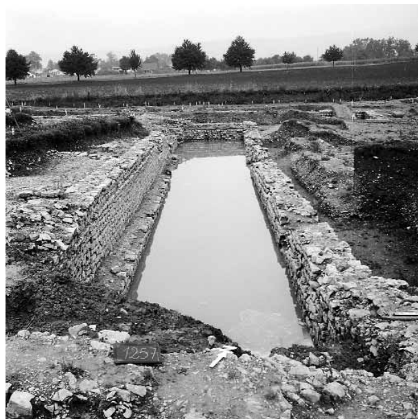
Abb. 119: Augst, Kurzenbettli (Grabung 1965.51), Westtrakt. Vollgelaufener Halbkeller 34 nach Regenguss. Von Süden.
