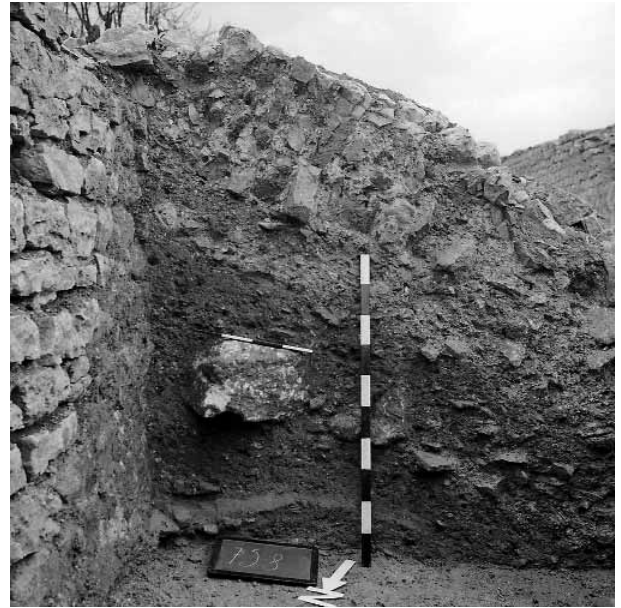
Abb. 52: Augst, Kurzenbettli (Grabung 1965.51), Westtrakt. Schuttkegel unter dem verstürzten Eingangsbereich in Mauer 38 in den Kellerraum 74a. Von Norden.
