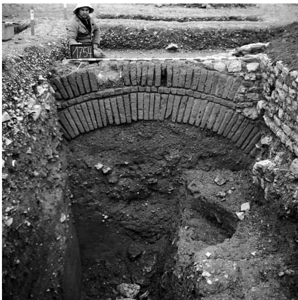
Abb. 55: Augst, Kurzenbettli (Grabung 1965.51), Westtrakt. Ansicht des Entlastungsbogens in Mauer 89 über dem zugeschütteten Sodbrunnen, neben Apsisraum 55. Von Norden.
