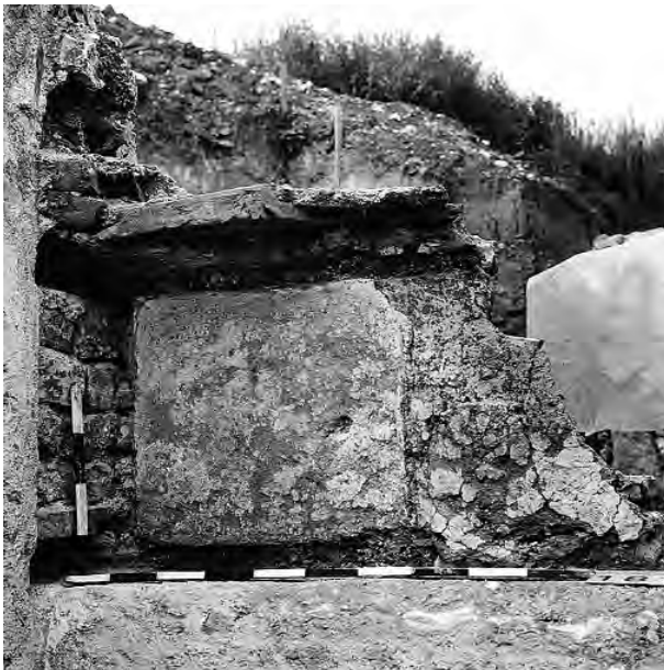
Abb. 64: Augst, Region 4,G (Grabung 1975.52). Ansicht der Nordostwand des Kellers (MR 4G01.B.7) mit der nördlichen Nische. Im Verputz zeichnen sich die Abdrücke von Holzbrettern der Ausfachung ab; Hohlräume in der Mauer MR 4G01.B.3 (links im Bild) belegen zudem, dass der Ansatz der horizontalen Bretter in die Mauer eingelassen war. Von Süden.
