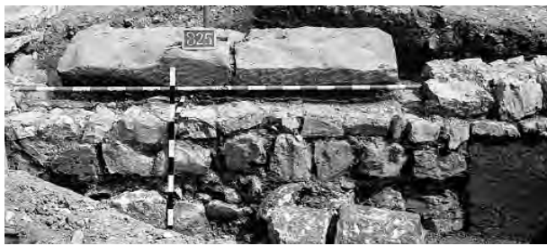
Abb. 103: Augst, Region 5,B (Grabung 1967.55). Die Mauer MR 5B01.BC.75 mit der Schwelle des Gebäudes 5B01.C. Auffallend die sehr unregelmässigen Mauersteine und rechts der in die Mauer verbauten Buntsandsteinquader. Von Nordwesten.
