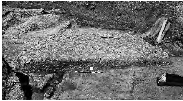
Abb. 92: Augst, Region 5,H (Grabung 1973.52). Schrägansicht der Steinsetzung So 5H02.2001, die den Mosaikboden im Raum 5H02.C.07 durchschlug. Von Südosten.
