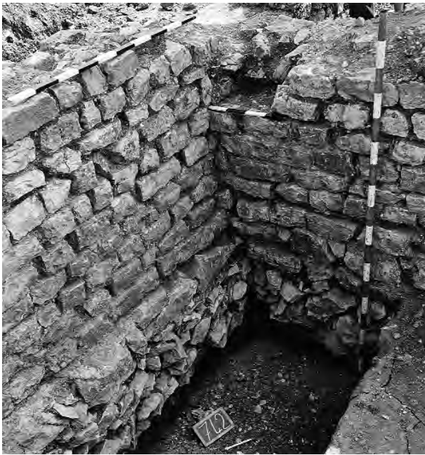
Abb. 101: Augst, Region 5,B (Grabung 1967.55). Ecke mit den Mauern MR 5B01.BC.128 (links) und MR 5B01.BC.129. Die Steinlagen im unteren Bereich der Mauer MR 5B01.BC.129 sind in der Horizontalen gegenüber jenen der Mauer MR 5B01.BC.128 leicht verschoben. Von Westen.
