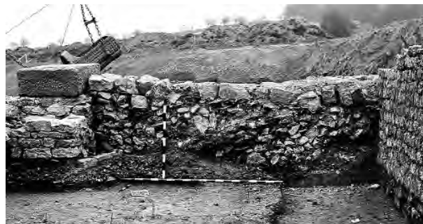
Abb. 109: Augst, Region 5,B (Grabung 1967.55). Die Mauer MR 5B01.Cc.147, eingespannt zwischen die ältere Mauer MR 5B01.BC.143 und das Pfeilerfundament Pf 5B01.BCab.07. Von Nordwesten.
