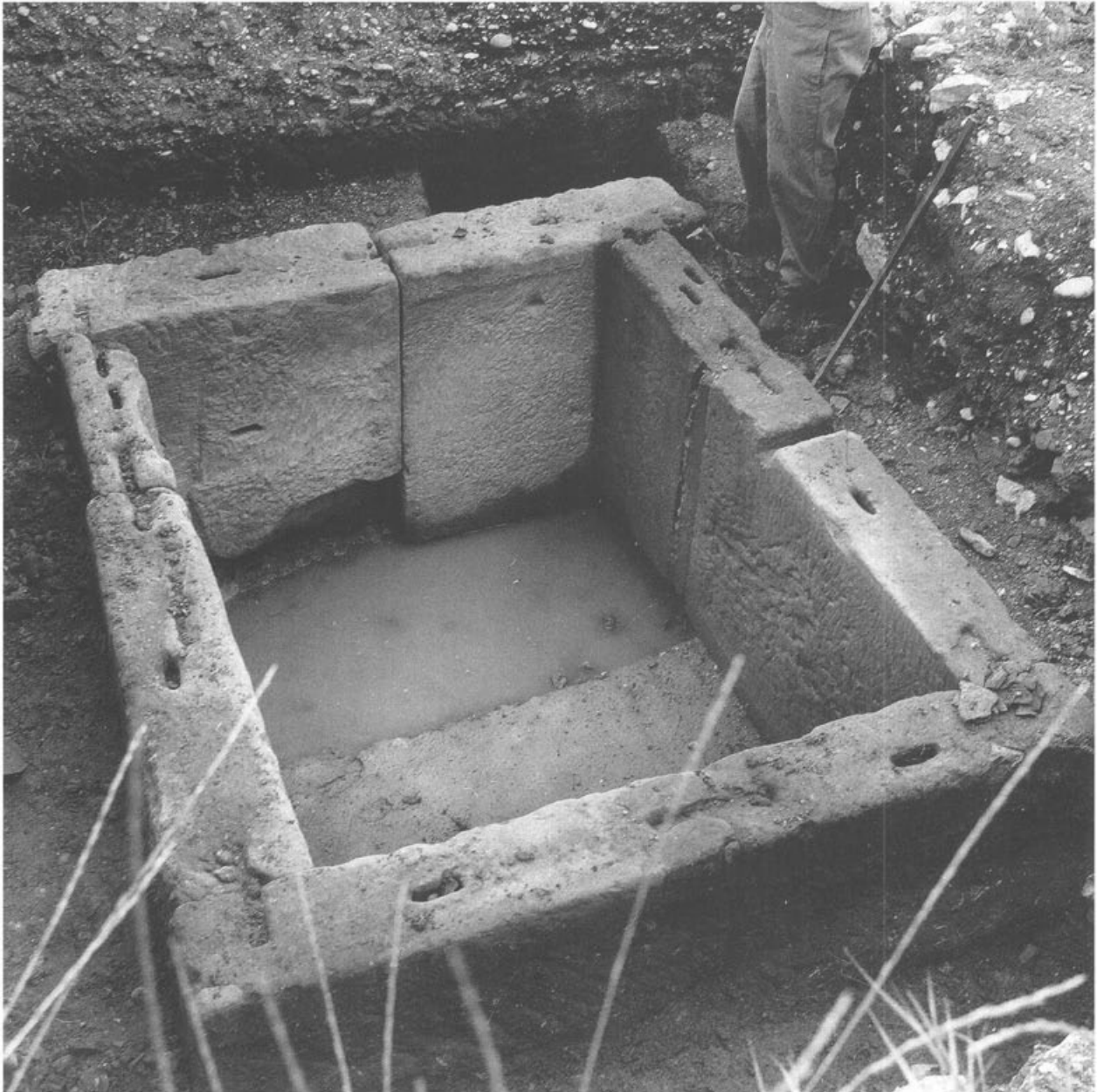
Abb. 1 Augst, Insula 44 (Grabung 1971.53). Der freigelegte Strassenbrunnen 7b unmittelbar vor der Bergung der Sandsteinplatten. Blick von Norden in die Ostrandstrasse; rechts hinter dem Mann steckt noch die Porticusmauer und Ostecke von Insula 44 im Boden. Gut sichtbar sind die Wolfslöcher in der Mitte der oberen Brüstungskanten der Steinplatten, die Nuten und Löcher für Eisenklammern zwischen den Steinen und die Einflussrinne auf dem rechten Brunnenrand. Ein rundes Auslaufloch liegt im Schatten des vorderen Beckenrandes. Grösse des ganzen Troges: 2,6 × 2,1 m.
