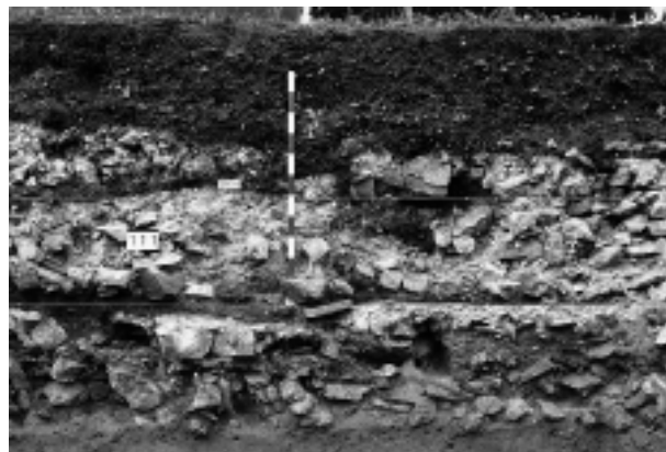
Abb. 9: Augst BL, Insula 1 – Befundzone D2 (Grabung 1991–1993.51). Ausschnitt aus dem Westteil von Profil I (Beil. 2). Zu erkennen sind auf der Kote von ca. 293.00 m ü. M. der insulazeitliche (H I) Mörtelgussboden des Praefurniums (links) und der leicht höher liegende Unterboden des hypokaustierten Sudatoriums (?) (rechts). Links vom Massstab ist das angeschnittene Ziegelgewölbe des schräg durch MR 20 verlaufenden Heizkanals zu erkennen (s. Abb. 6, C21, C22). Die auf den Mörtelgussböden liegende, dunkle Holzkohle- und Aschenschicht stammt aus der Benützungszeit (H I). Sie wird von einem stark mit Mörtel durchsetzten Mauerschuttpaket überlagert, das – nach der befestigungszeitlichen Ausplünderung der Hypokaustinstallationen (H IV) – als Füllschicht eingebracht worden war. Auf der Oberkante des Mauerschutts ist am rechten Bildrand noch der Überrest des bei neuzeitlichen Freilegungsarbeiten (H VII) weitgehend zerstörten, befestigungszeitlichen Mörtelgussbodens M 4 zu erkennen (H IV). Am linken Bildrand zeichnen sich die auf der Kote 293.50 m ü. M. liegenden befestigungszeitlichen Kulturschichten (H IV) auf dem eingefüllten Mauerschutt als dunkles, humoses Band ab. Dieses wird seinerseits von einem Mauerschuttpaket überlagert, das bei jüngeren befestigungszeitlichen Abbrucharbeiten (H IV) oder beim späteren Verfall (H VI) der östlich gelegenen MR 19 anfiel (s. Beil. 2, 74).
