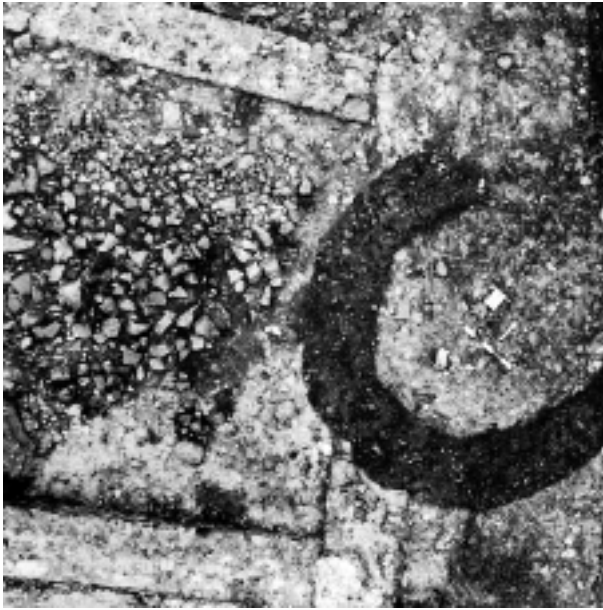
Abb. 30: Augst BL, Insula 1 und Insula 2 – Befundzonen D7 und D9 (Grabung 1991–1993.51). Blick auf die freipräparierte Unterkante der hufeisenförmigen neuzeitlichen Störung (H VII) im Ostteil der Nordportikus der Insula 1 (H I). Die Störung hat die hier weitgehend aus dem Verfallsschutt der umliegenden Mauerzüge zusammengesetzte, nachbefestigungszeitliche Abdeckschicht (Reduktionshorizont; H VI) und die auf der gleichen Kote liegende Krone der Nord-Süd verlaufenden MR 33/7 durchschlagen (s. auch Beil. 5,78). Auf der Unterkante der Störung zeichnet sich die Oberkante der dunklen, humosen befestigungszeitlichen Kulturschichten (H IV) ab. Oben im Bild MR 13, unten MR 9.
