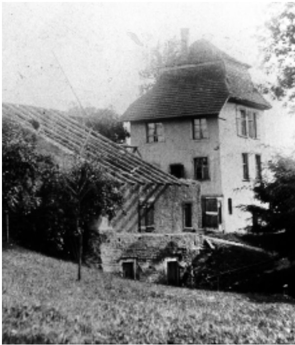
Abb. 112: Augst BL, Nordrandstrasse – Befundzone D13 und D14 (Grabung 1991–1993.51). Blick über den im Jahre 1919 noch mit Obstbäumen bepflanzten, talseitigen Bereich der Grabungsfläche. In der Bildmitte liegt das vermutlich im 17. Jahrhundert unter Einbezug einer insulazeitlichen Hangstützmauer (MR 16) errichtete und im Spätherbst 1919 beim Bau der Garage der heutigen Villa Clavel (s. Abb. 1) abgebrochene Ökonomiegebäude. Im Hintergrund ist der um 1669 errichtete und im Jahre 1920 in die Villa Clavel integrierte Wachturm zu erkennen (s. auch Abb. 1). Der an dem heruntergezogenen Turmdach als spätere Zutat erkennbare Anbau stammt aus der Zeit um 1800, als der Wachturm in ein «Lust- und Rebhaus» umgewandelt wurde. Er wurde vor der Eingliederung des Wachthauses in die Villa Clavel (s. Abb. 1) wieder abgerissen. Blick nach Westen.
