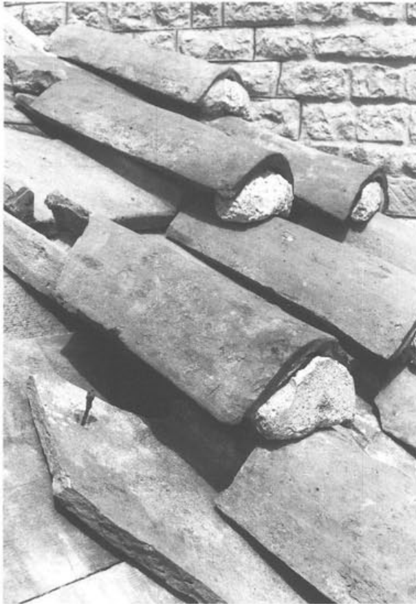
Abb. 126 Augst BL, Insulae 1 und 2. Detail des rekonstruierten Ziegeldaches von Abb. 125. Im Vordergrund eine tegula mit Eisennagel und Nagelloch.
