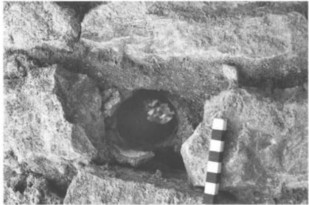
Abb. 16 Augst BL, Insula 1. Phase 3.1. Mittlerer Entlastungsbogen (Mauer 52), Detail eines Gerüstbalkenlochs. Der Durchmesser des Holzes beträgt ca. 6,5 cm.
