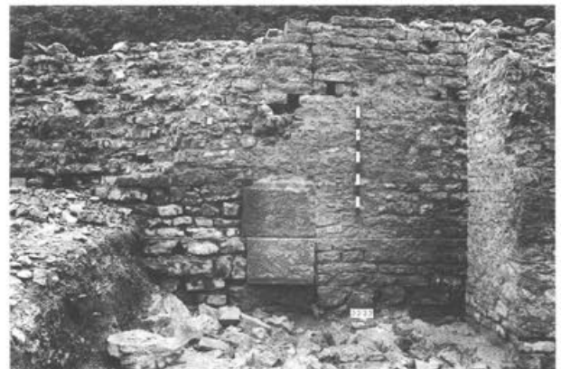
Abb. 85 Augst BL, Insulae 1 und 2. Mauer 4 und Mauer 17, Nordseite. In der Bildmitte, im Bereich der Buntsandsteinquader, befindet sich die Stossfuge, welche die beiden Mauern voneinander trennt (vgl. Beilage 8).
