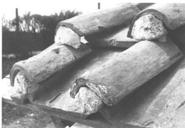
Abb. 123 Augst BL, Insulae 1 und 2. Detail des rekonstruierten Ziegeldaches von Abb. 125. Die miteinander vermörtelten imbrices bilden stabile Rippen, welche die darunterliegenden tegulae festhalten. Man beachte die leicht abgeknickte unterste Tegulareihe.
