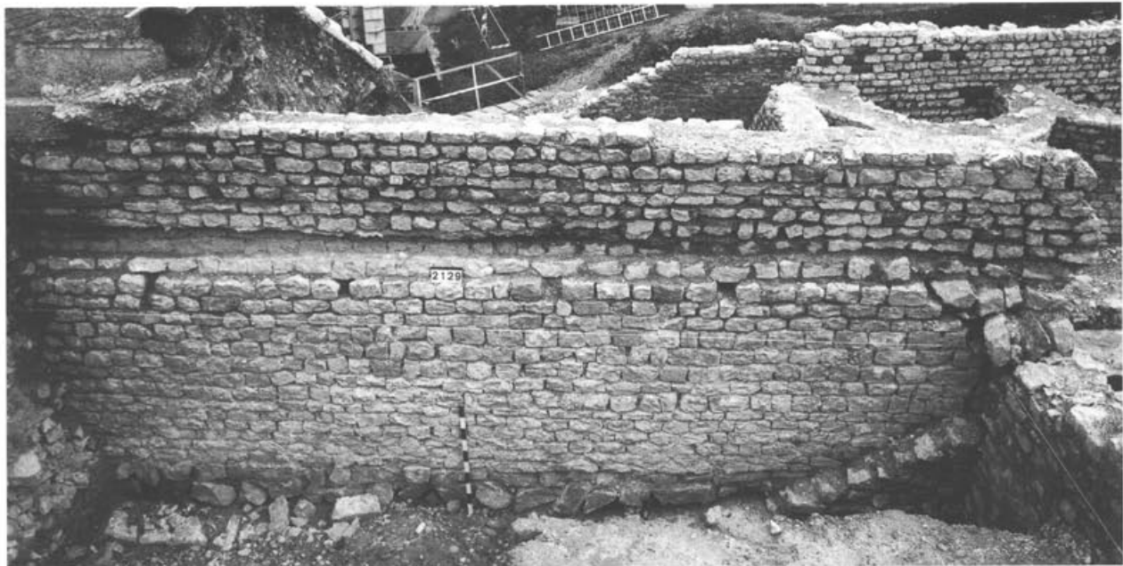
Abb. 92 Augst BL, Insula 1. Mauer 13 und Mauer 40, Südseite. Mauer 13 ist in diesem Bereich auf die Abbruchkrone von Mauer 40 gestellt.
