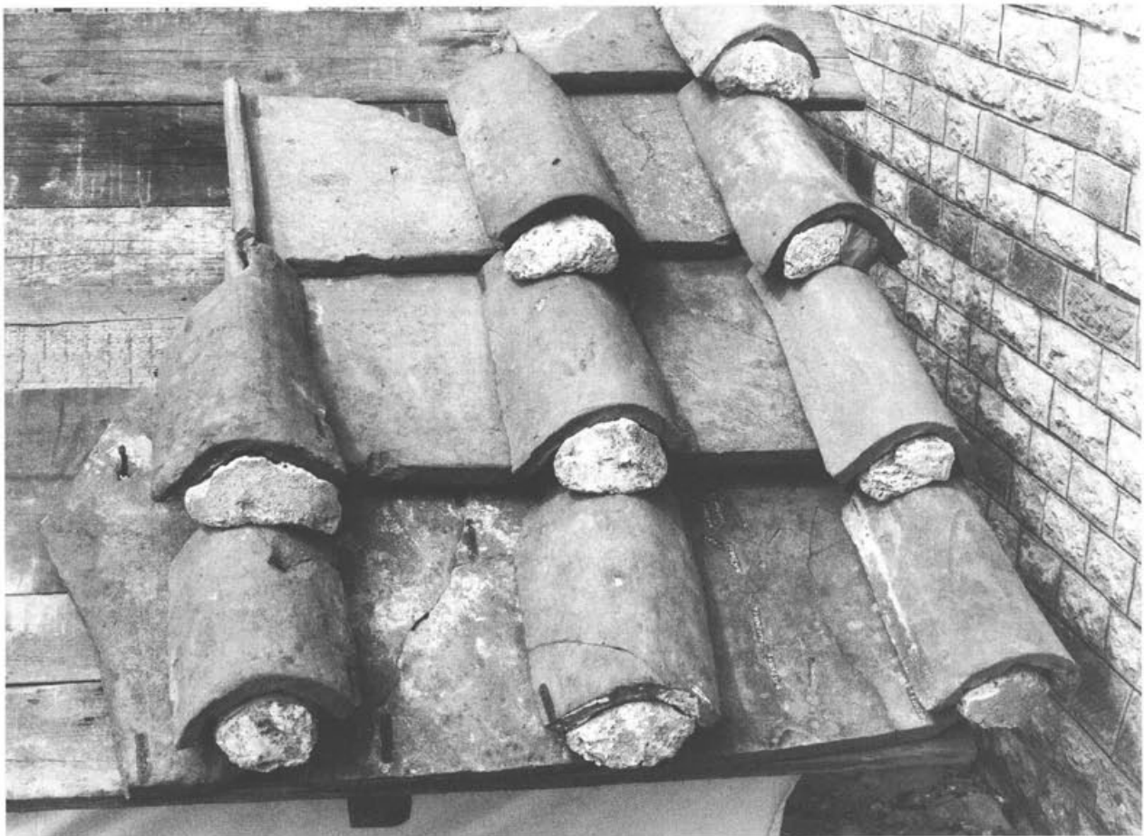
Abb. 125 Augst BL, Insulae 1 und 2. Rekonstruktionsversuch eines römischen Ziegeldaches, basierend auf den Funden aus den Dachverstürzen der Grabung 1991.51/1992.51. Die Dachneigung beträgt 26,6°.
