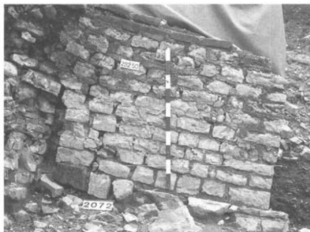
Abb. 107 Augst BL, Insula 2. Stützpfeiler MR 35, Nordseite mit Fugenstrich und Ziegeldurchschuss. Die Gründe für das Absinken des Pfeilers sind unklar (vgl. Beilage 8).
