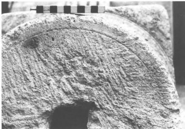
Abb. 121 Augst BL, Insulae 1 und 2. Lagerfläche eines Säulenschaftes mit gehauenen, leicht vertieftem Mittelteil und abgedrehtem Randbereich. Die Vertiefung im Zentrum diente zum Einspannen auf der Drehbank.
