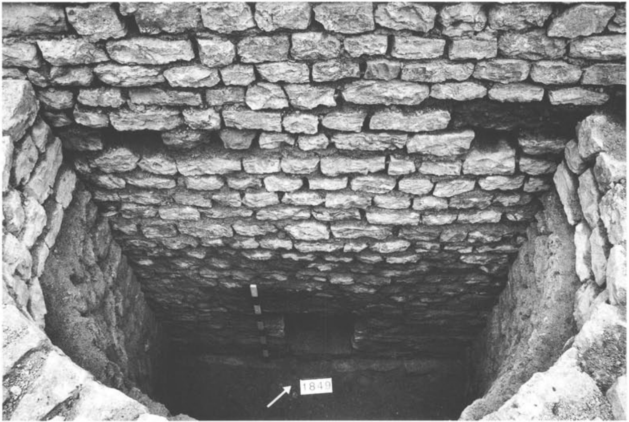
Abb. 17 Augst BL, Insula 1. Phase 3.1. Mauer 17, Ansicht an die Südseite im Bereich des westlichen Entlastungsbogens (Mauer 51). Erkennbar sind zwei Balkenlöcher, die bei der Errichtung der Entlastungsbögen zur Fixierung einer Gerüstkonstruktion dienten. Das linke Balkenloch wurde speziell zu diesem Zweck aus der Mauerschale herausgebrochen, während das rechte bereits zu einem früheren Zeitpunkt, in Zusammenhang mit dem Bau von Mauer 17, entstanden ist und bei der Errichtung der Entlastungsbögen wiederverwendet wurde. Im unteren Bereich ist der Durchlass für den Abwasserkanal aus der Zeit der Älteren Steinbauten zu erkennen.
