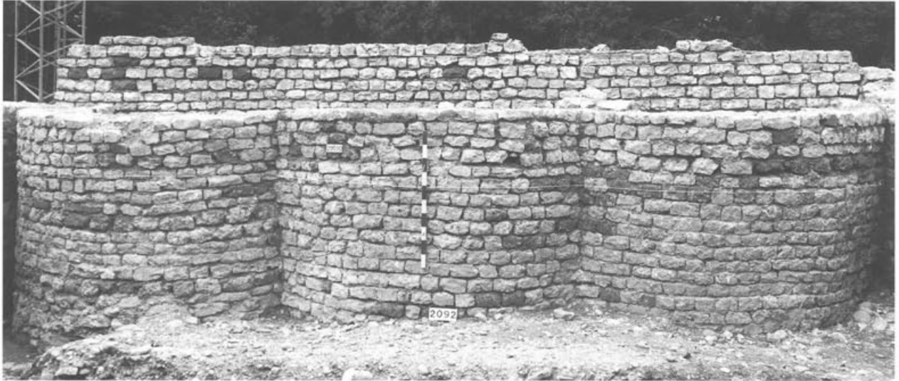
Abb. 112 Augst BL, Insula 1. Entlastungsbögen (MR 51–53), Südseite. Die Entlastungsbögen sind an die ältere Mauer 17 angebaut.
