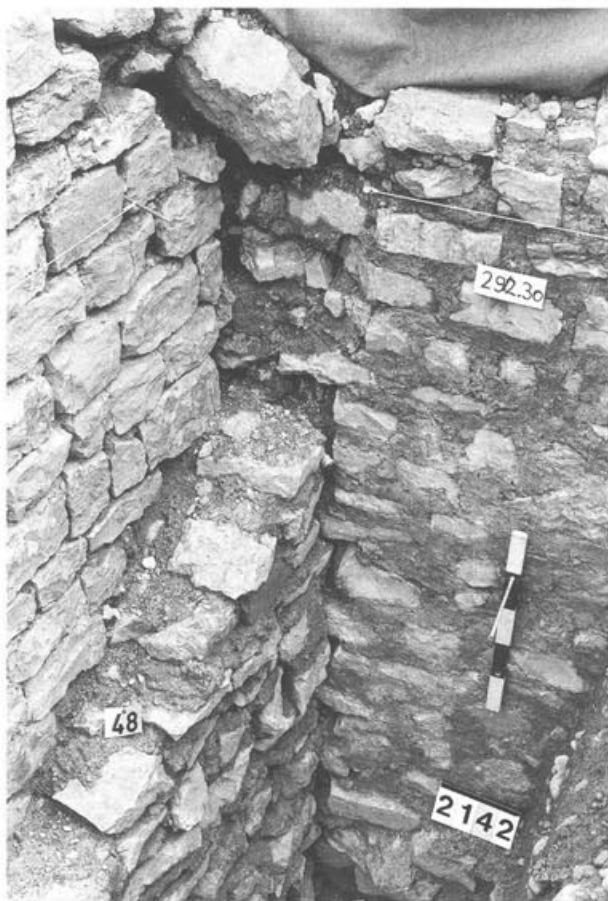
Abb. 25 Augst BL, Insula 1. Raum B6/B7. Ansicht an die Verzahnung der Mauern 48 (links unten) und 24/49 (rechts). Bei dem links auf Mauer 48 aufliegenden Mauerstück handelt es sich um Mauer 40 der Jüngerer Steinbauperiode.
