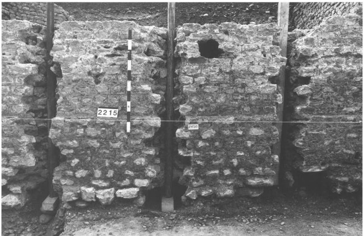
Abb. 99 Augst BL, Insula 2. Kellermauer 32, Nordseite. Im Bereich der ehemals vermauerten Hölzer ist die Mauer- schale entfernt worden, um die entstandenen Hohlräume zu dokumentieren. Zur Verdeutlichung des Befun- des sind entsprechende Hölzer hineingestellt worden.
