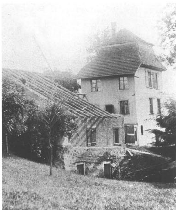
Abb. 7 Augst BL. Blick von Osten an das Reb- und Lusthaus aus dem 18. Jahrhundert mit dem im Abbruch befindlichen Ökonomiegebäude. Der untere Teil der Aussenmauer des Ökonomiegebäudes besteht aus römischem Mauerwerk, in das nachträglich Fenster eingebaut wurden. Die wiederverwendete römische Mauer ist die westliche Fortsetzung von Mauer 16 der Grabung 1991/1992.51. Das Rebhaus ist in den Nordflügel der Villa Clavel integriert worden.
