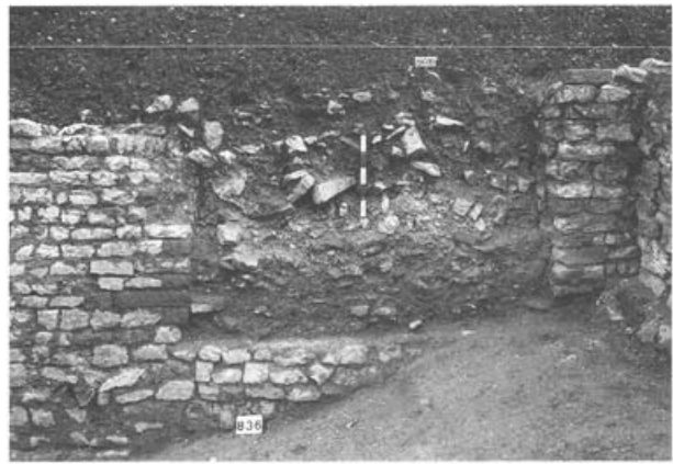
Abb. 63 Augst BL, Insula 2. Raum B1/B2. Zugang in Mauer 2/3 zum Hinterhof. Die Gewände weisen einen Eckverband aus Buntsandsteinquader auf.
