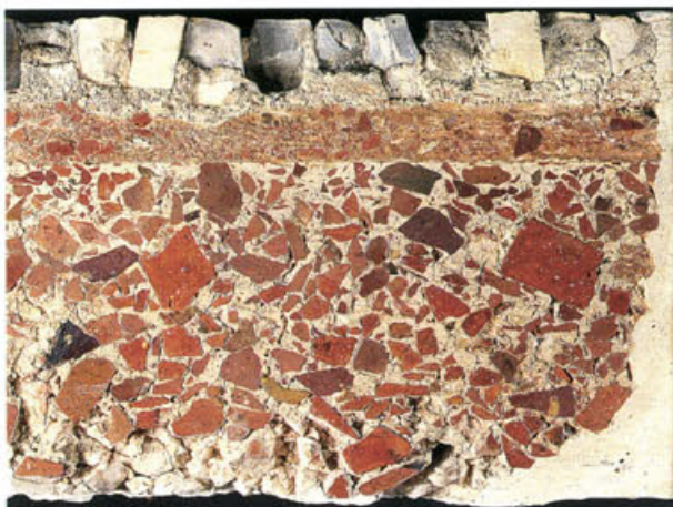
3 Insula 32, Zentralthermen. Fragment II,2. Querschnitt durch die Bettung im Caldarium.
