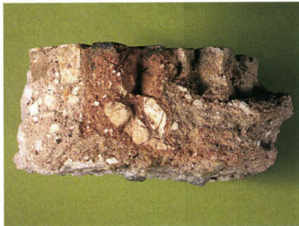
4 Insula 31. Querschnitt durch die erhaltene Bettung: Das schwarze zweireihige Linienband ist in einen anderen Mörtel gesetzt als die seitlich anschliessende weisse Fläche.
