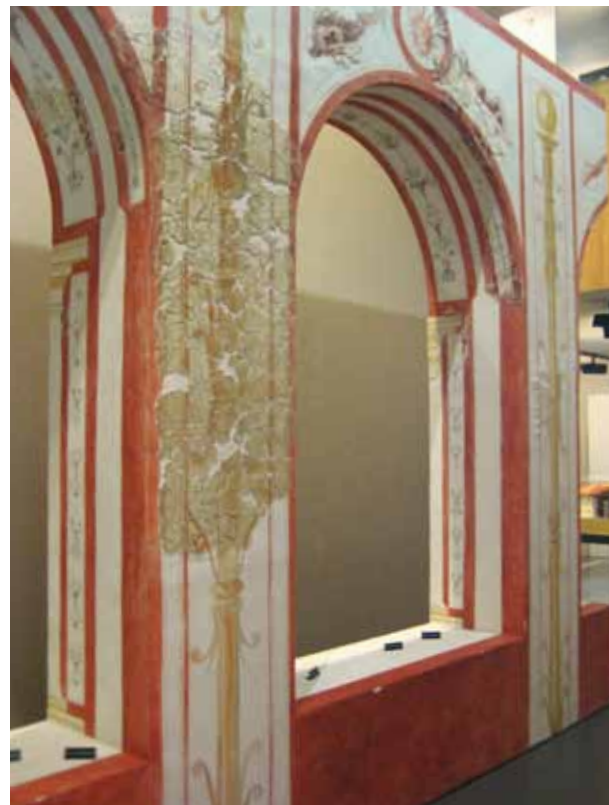
Abb. 12: Vallon/FR, villa rustica. Gemauerte und bemalte Bogenportikus als östliche Begrenzung des Innenhofs. Spuren am Verputz weisen darauf hin, dass die oberen Zonen der Bogenöffnungen vermutlich verglast gewesen sind und dass zudem die Interkolumnien bei Bedarf mit Holzläden verschlossen werden konnten.
