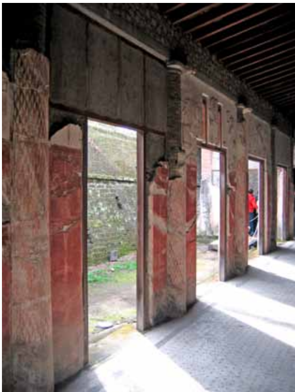
Abb. 11: Oplontis/Torre Annunziata (I), Villa «A» (sogenannte Villa di Poppea). Südperistyl mit partiell geschlossenen Interkolumnien. Die Konstruktion aus opus craticium entstand vermutlich erst sekundär im Zug einer Umbaumaßnahme.
