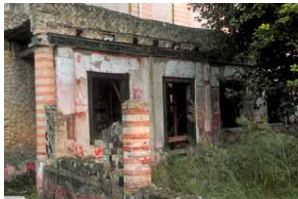
Abb. 15: Herculaneum (I), Casa dell'Atrio a Mosaico. Ostseite des Peristyls mit partiell geschlossenen Interkolumnien. Die Konstruktion aus opus craticum entstand vermutlich erst sekundär im Zug einer Umbaumaassnahme.
