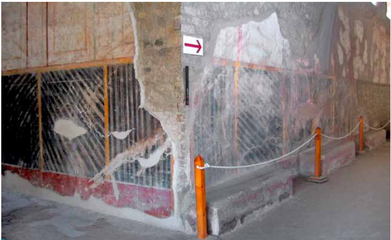
Abb. 28: Oplontis/Torre Annunziata (I), Villa «A» (sogenannte Villa di Poppea). Servicekorridore 76 (links) und 46 (rechts) mit wohl Marmor imitierenden Malereien in sogenanntem «Zebrastreifen-Dekor» im unteren Bereich und weissgrundiger Bemalung in den oberen Wandzonen. In Korridor 46, der zum Serviceperistyl 32 führt, sind die gemauerten Sitzbänke in der rot bemalten Sockelzone erkennbar. Blick nach Südwesten.
