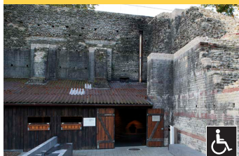
Tempelstützmauer & Backstube Mur du temple et fournil Temple wall and bakery Muri di un tempio e panificio
