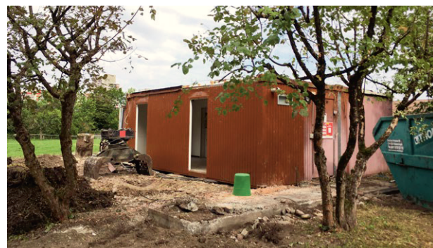
Der Pavillon der Fundrestaurierung und das Container-Provisorium bei der Gesslerscheune wurden nach dem Umzug im Sommer 2021 rückgebaut. Fotos Susanne Schenker
