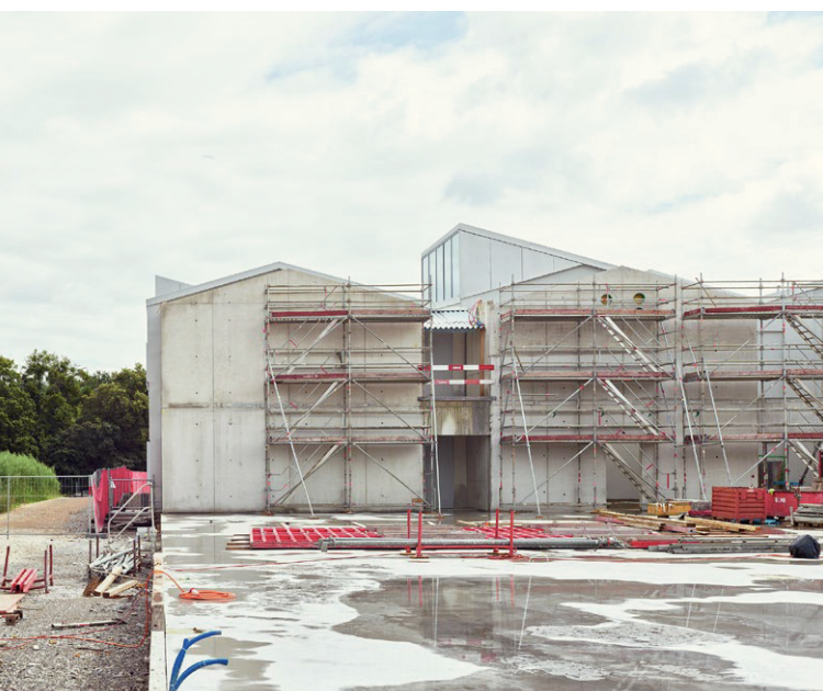
Das Sammlungszentrum wird nach dem Prinzip «Bauen über den Ruinen» erstellt. Möglichst ohne Bodeneingriffe und Grabungen wird direkt über einer Terrainaufschüttung und einer Betonplatte der Stahlbau errichtet. Im Bild die Betonplatte der zweiten Etappe, die zurzeit direkt an das bereits bestehende Gebäude angebaut wird. Foto Roman Weyeneth
